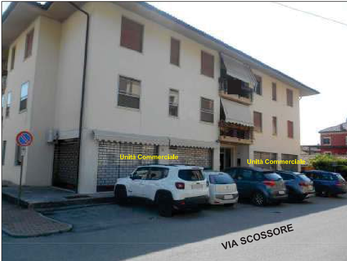
CODOMINIO SAN CARLO 1 PROSPETTO OVEST CON INGRESSO SU VIA SCOSSORE
