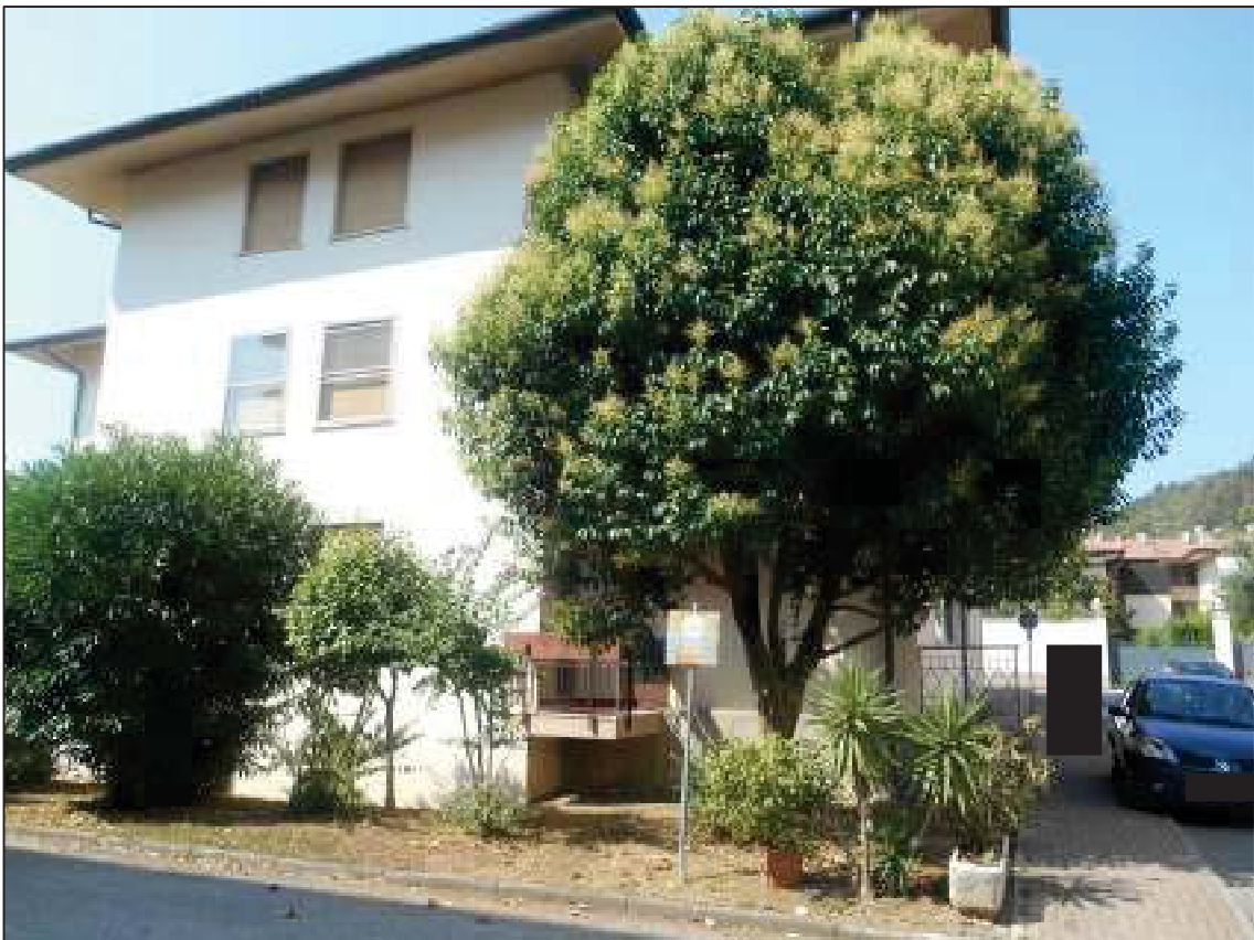
CODOMINIO SAN CARLO 1 PROSPETTO EST VISTA DALLA RAMPA DI ACCESSO AI GARAGE
