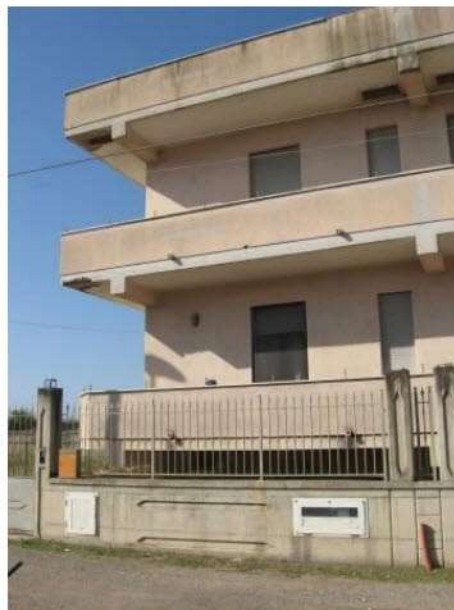
Figura 8 facciata est del fabbricato a cui appartengono gli immobili pignorati
