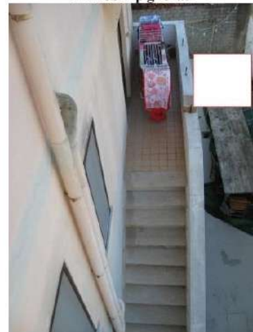
Figura 10 rampa di scale esterna per accesso al LOTTO N.2
