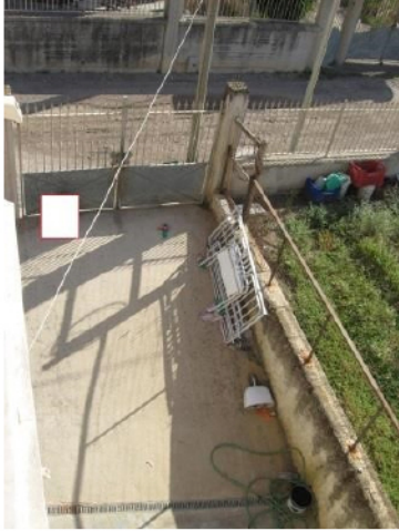
Figura 9 cortile comune di accesso di cui al sub 5 della particella 1496 del foglio 25
