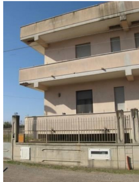
Figura 8 facciata est del fabbricato a cui appartengono gli immobili pignorati
