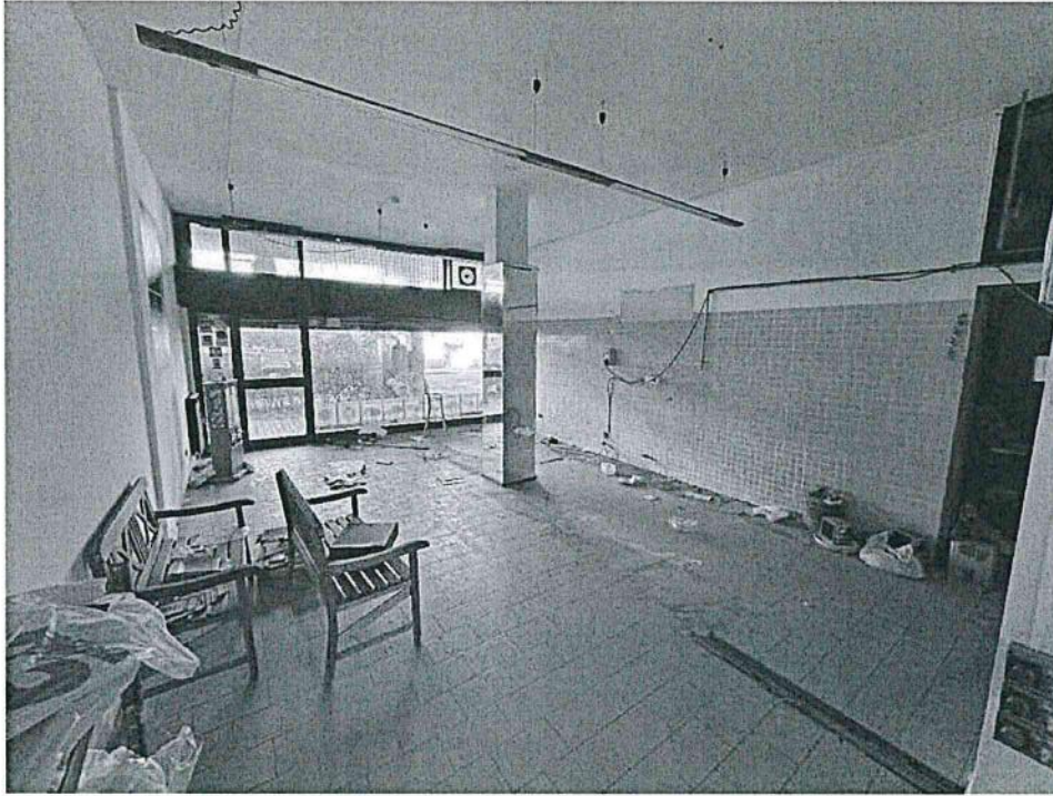
Locale 1 - Principale (foto 4)
