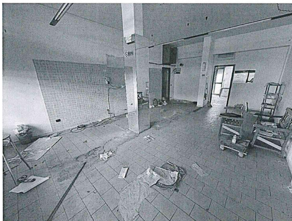
Locale 1 - Principale (foto 1)
