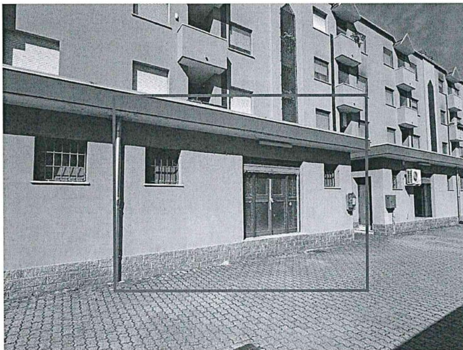
Retro negozio - Vista da corsello carraio (foto 7)
