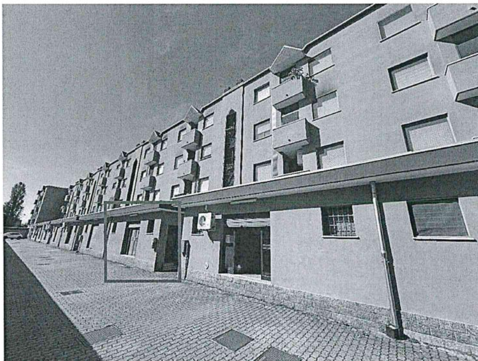
Fabbricato condominiale e retro negozio - Vista da corsello carraio (foto 1)
