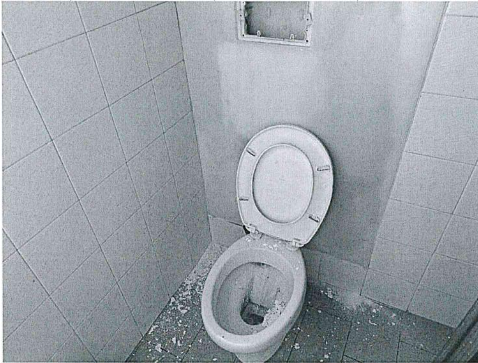
Dettaglio - Sanitari (foto 1)
