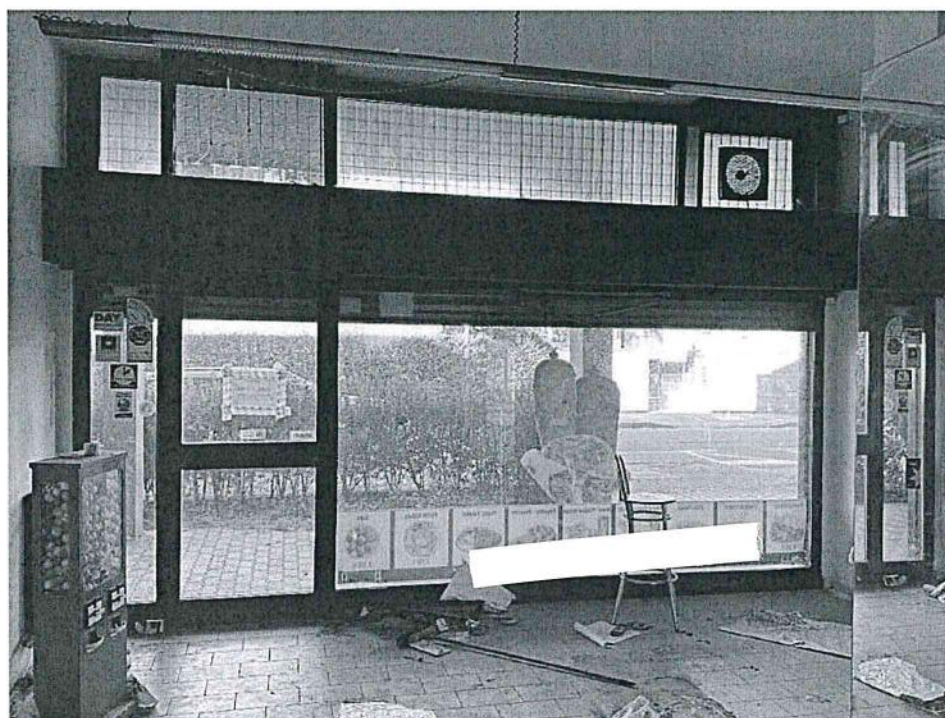
Dettaglio - Serramenti (foto 2)
