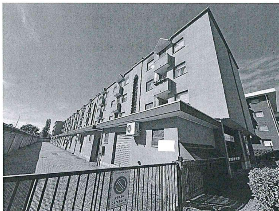
Fabbricato condominiale - Accesso carraio da Via Vivaldi
