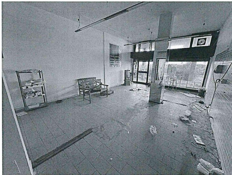
Locale 1 - Principale (foto 3)
