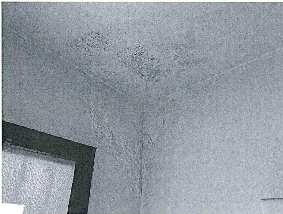
Dettaglio - Infiltrazioni
