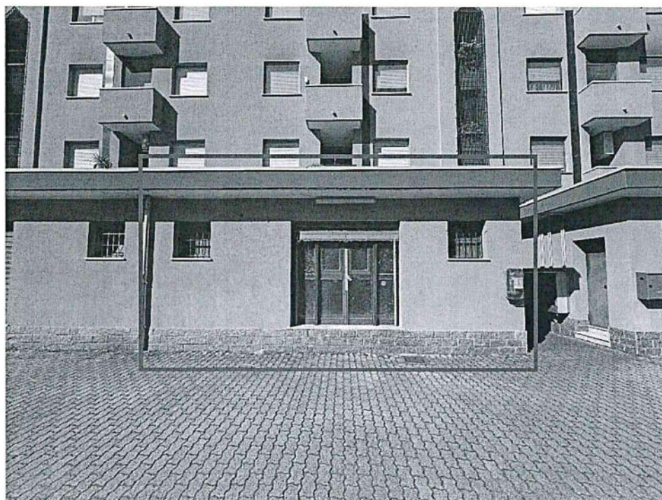
Retro negozio - Vista da corsello carraio (foto 5)
