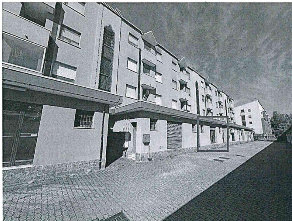
Fabbricato condominiale e retro negozio - Vista da corsello carraio (foto 2)
