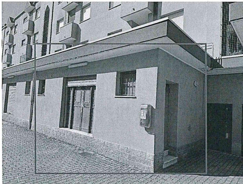
Retro negozio - Vista da corsello carraio (foto 2)
