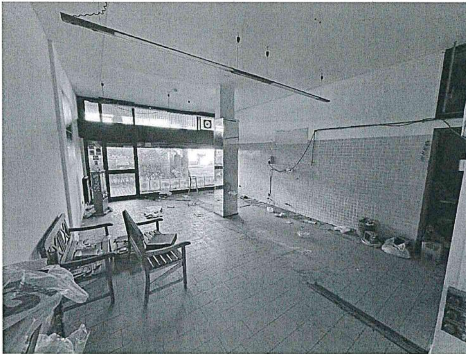
Locale 1 - Principale (foto 4)
