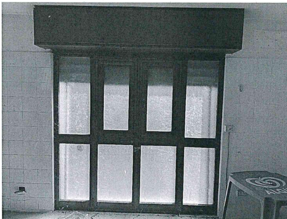
Dettaglio - Serramenti (foto 1)
