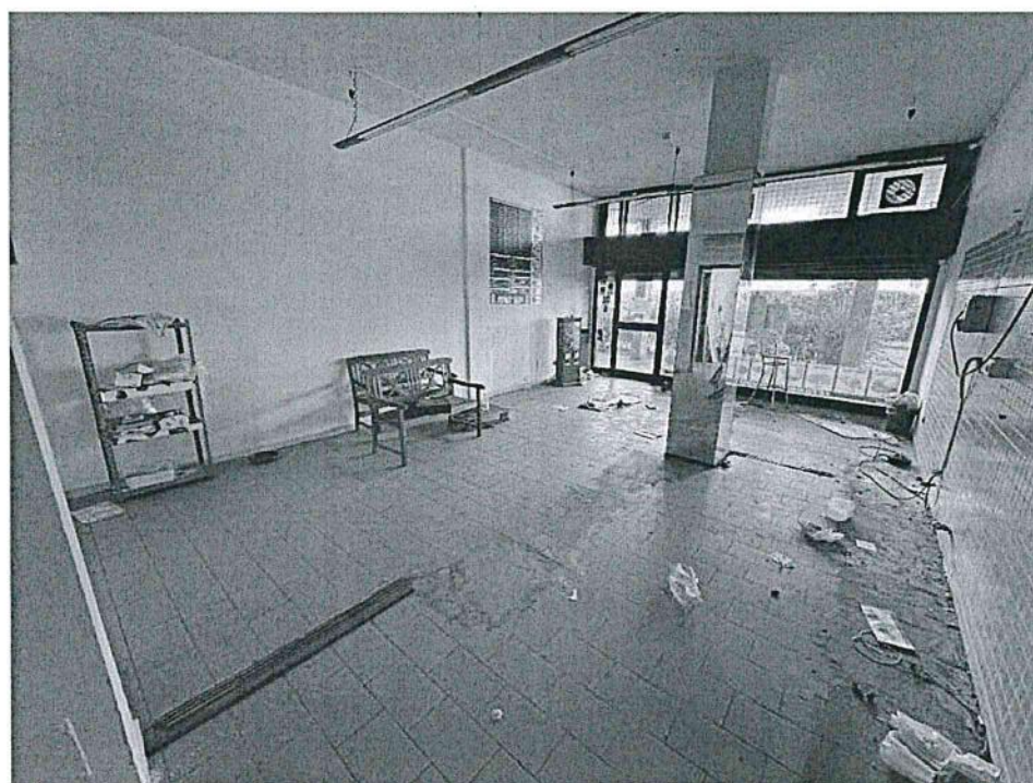
Locale 1 - Principale (foto 3)
