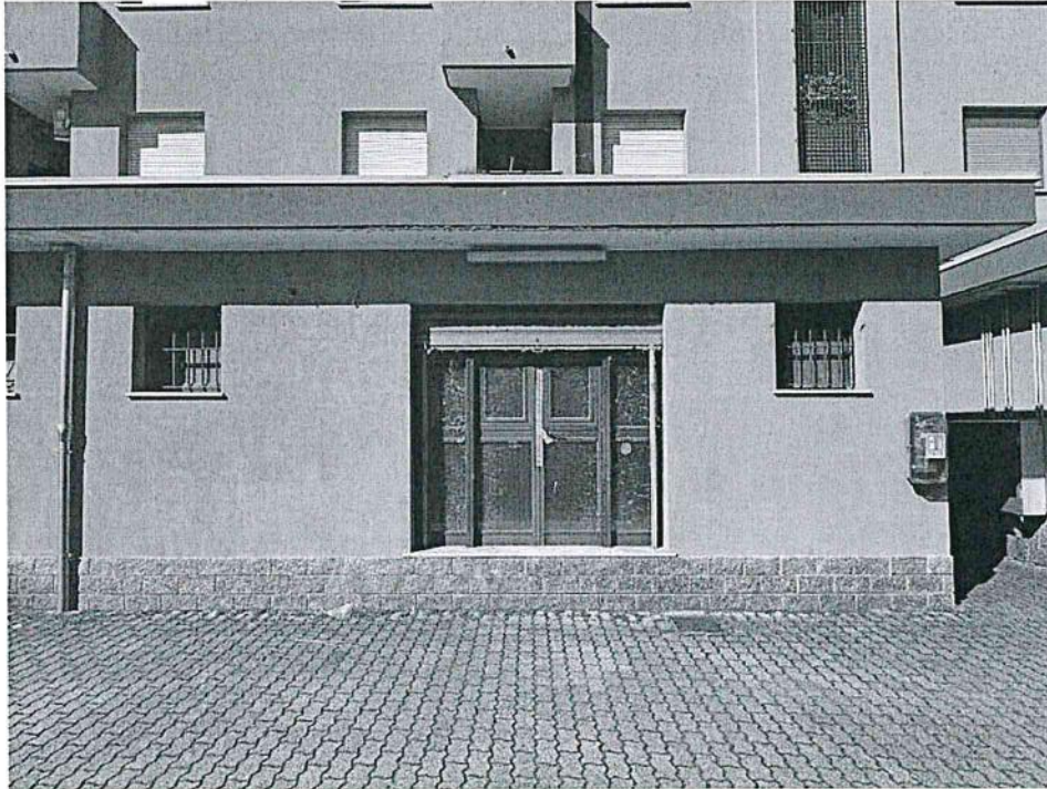
Retro negozio - Vista da corsello carraio (foto 6)
