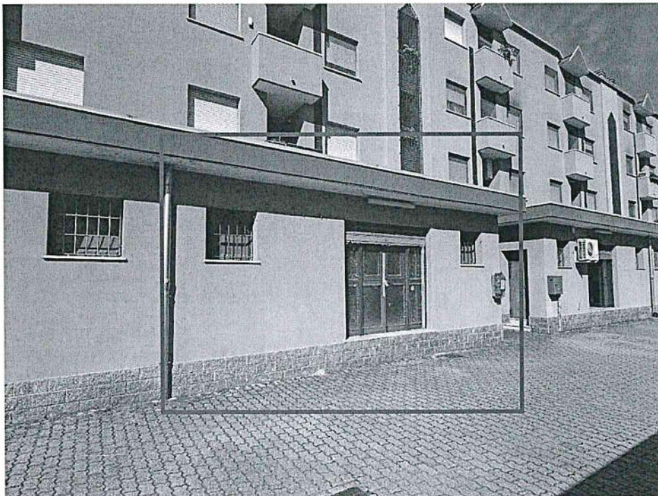
Retro negozio - Vista da corsello carraio (foto 7)
