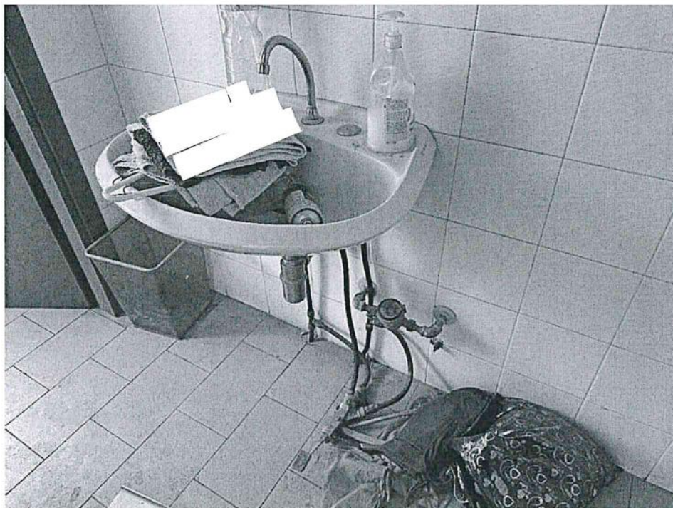
Dettaglio - Sanitari (foto 2)
