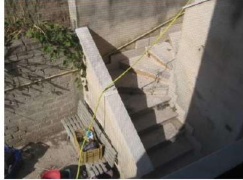
Figura 10 rampa di scale esterna per accesso al LOTTO N.3
