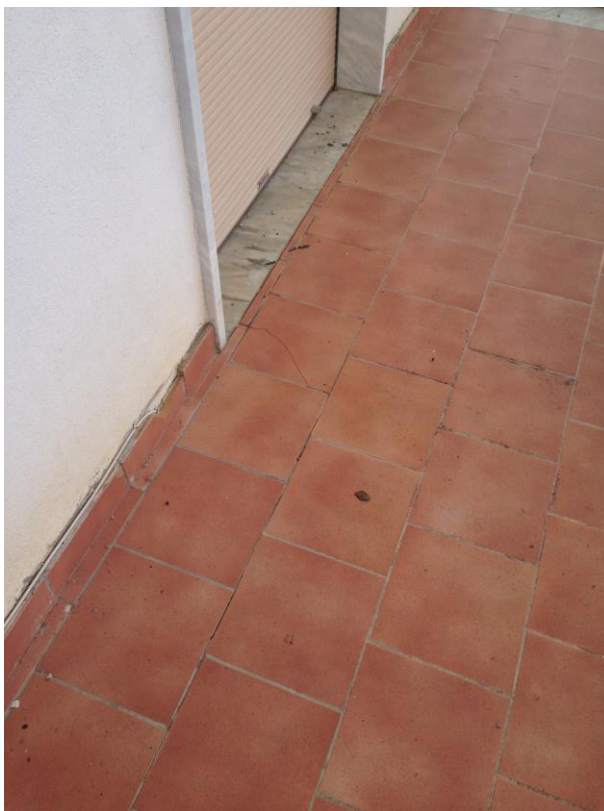
Foto 19 e 20: balcone esterno da cui si ravvisano evidenti fenomeni di deterioramento della pavimentazione
