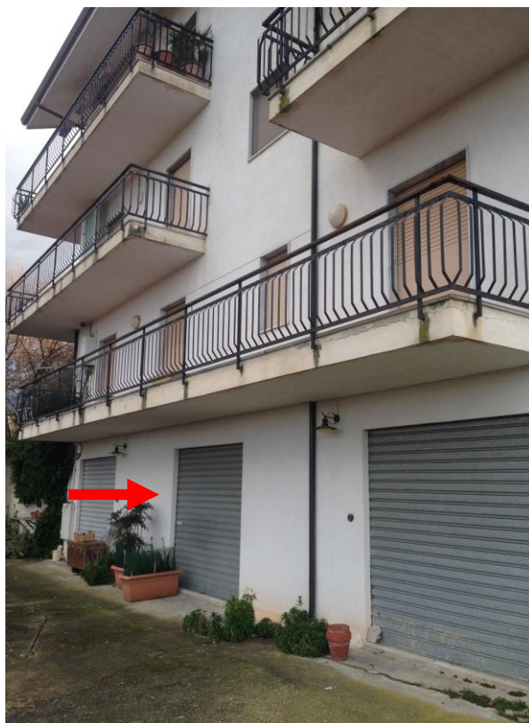
Foto 21: facciata lato N
