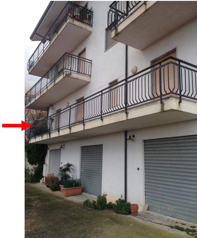
Foto 3: facciata lato N
