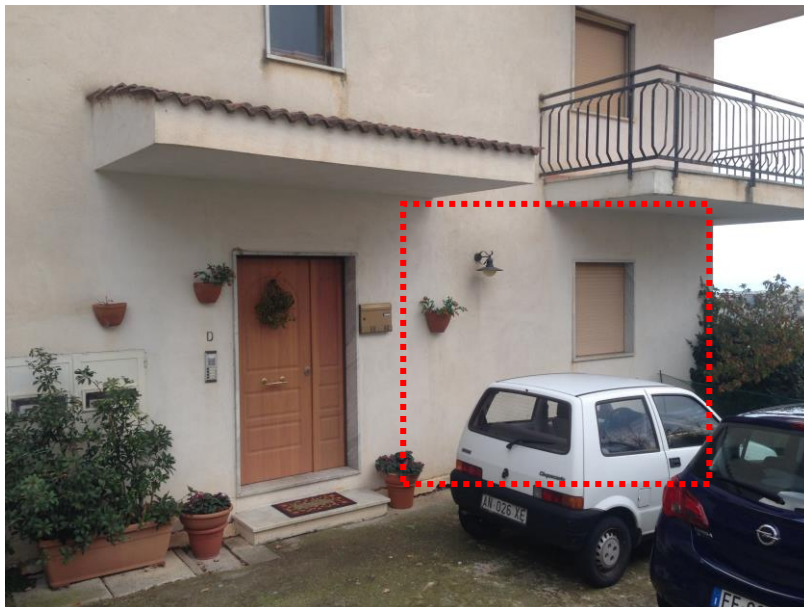
Foto 1: ingresso dal piazzale esterno
