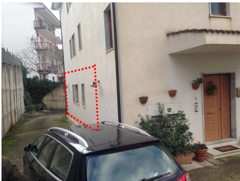
Foto 2: ingresso dal piazzale esterno
