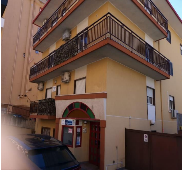
Foto n° 1 Portone accesso immobile
