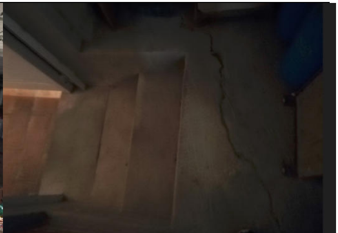
CREPA VISTOSA A PAVIMENTO
