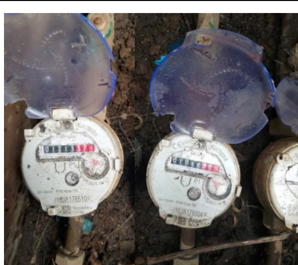
CONTATORE ACQUA POTABILE DENTRO POZZETTO STRADALE
