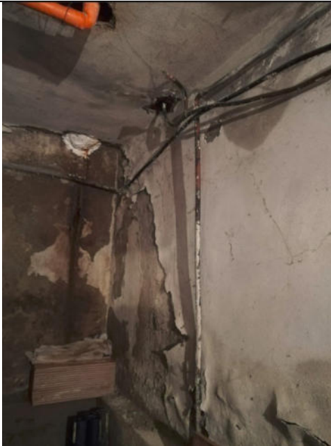
PARETI AMMALORATE CANTINA 2
