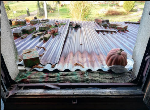
Vista della tettoia dalla finestra del soggiorno
