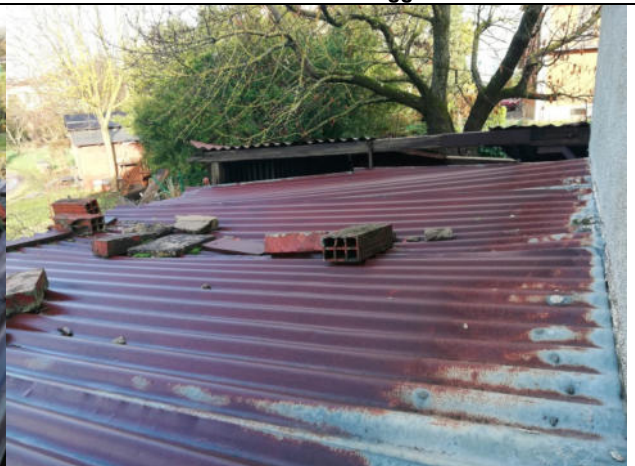
Vista tettoia lato retro
