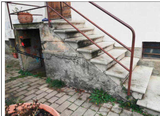
Accesso all'abitazione Piano Primo
