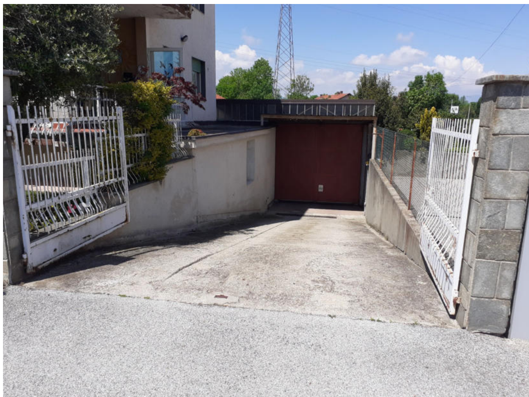
FOTO 4: RAMPA CARRAIA DI ACCESSO ALL'INTERRATO
