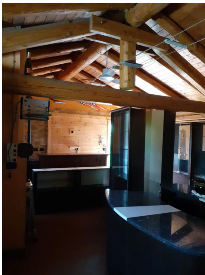
FOTO 24: INTERNO AUTORIMESSA (USO TAVERNETTA)
