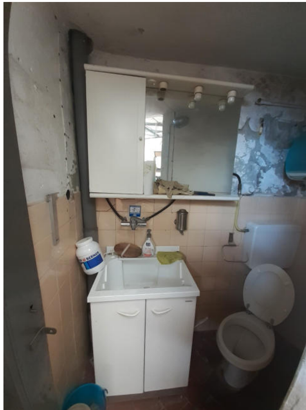
FOTO 18: SERVIZIO IGIENICO DEL LOCALE MAGAZZINO PIANO SEMINTERRATO
