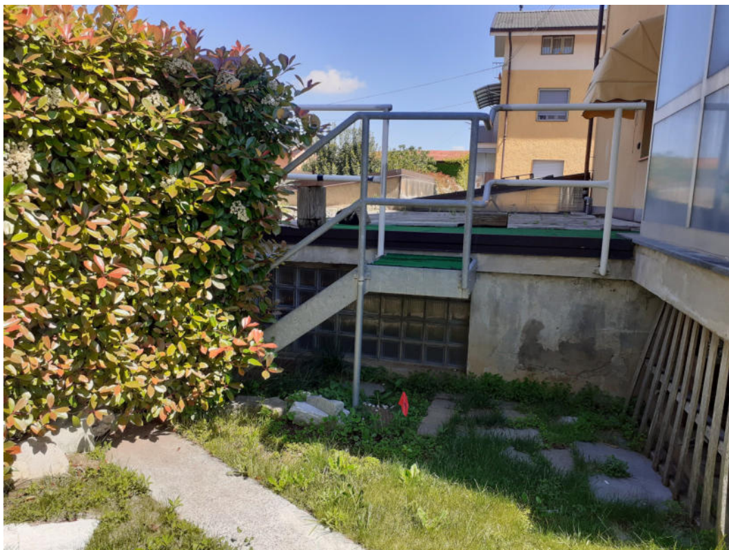
FOTO 15: SCALETTA DI ACCESSO AL LASTRICO SOLARE
