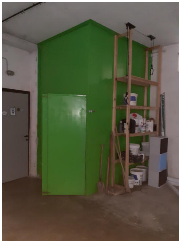
FOTO 19: ESTERNO LOCALE DEPOSITO AL PIANO SEMINTERRATO
