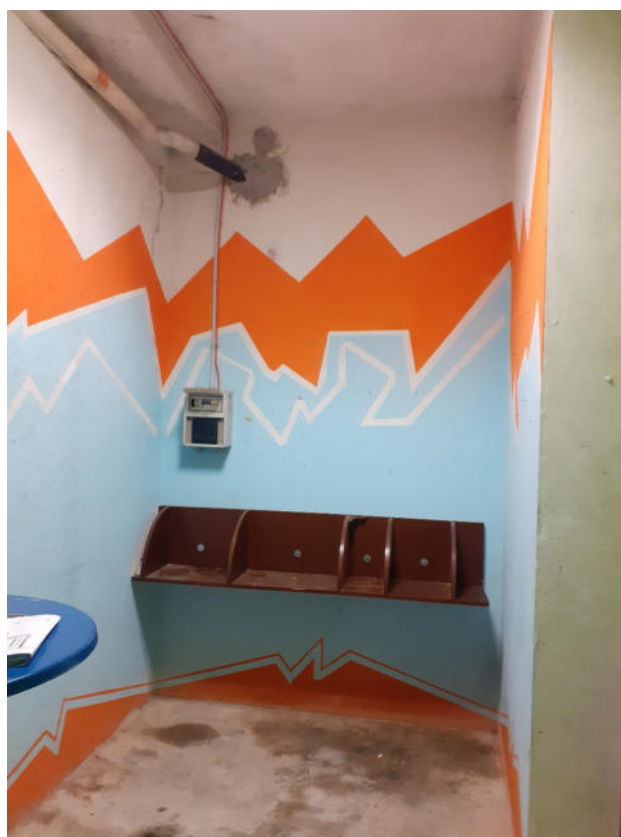
FOTO 20: INTERNO LOCALE DEPOSITO AL PIANO SEMINTERRATO
