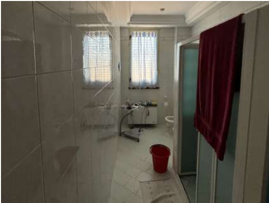
Foto n. 27 – Piano primo: servizio igienico
