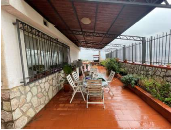
Foto n. 7 – Terrazza piano terra prospetto sud
