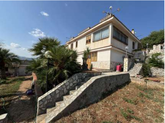
Foto n. 6 – Prospetto nord/est fabbricato princip.
