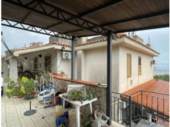
Foto n. 4 – Prospetto ovest fabbricato principale
