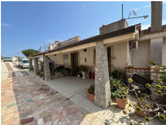
Foto n. 3 – Prospetto ovest fabbricato principale
