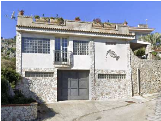
Foto n. 29 – Accesso piano terra dalla strada
