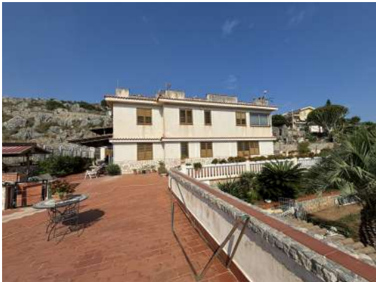
Foto n. 5 – Prospetto est fabbricato principale
