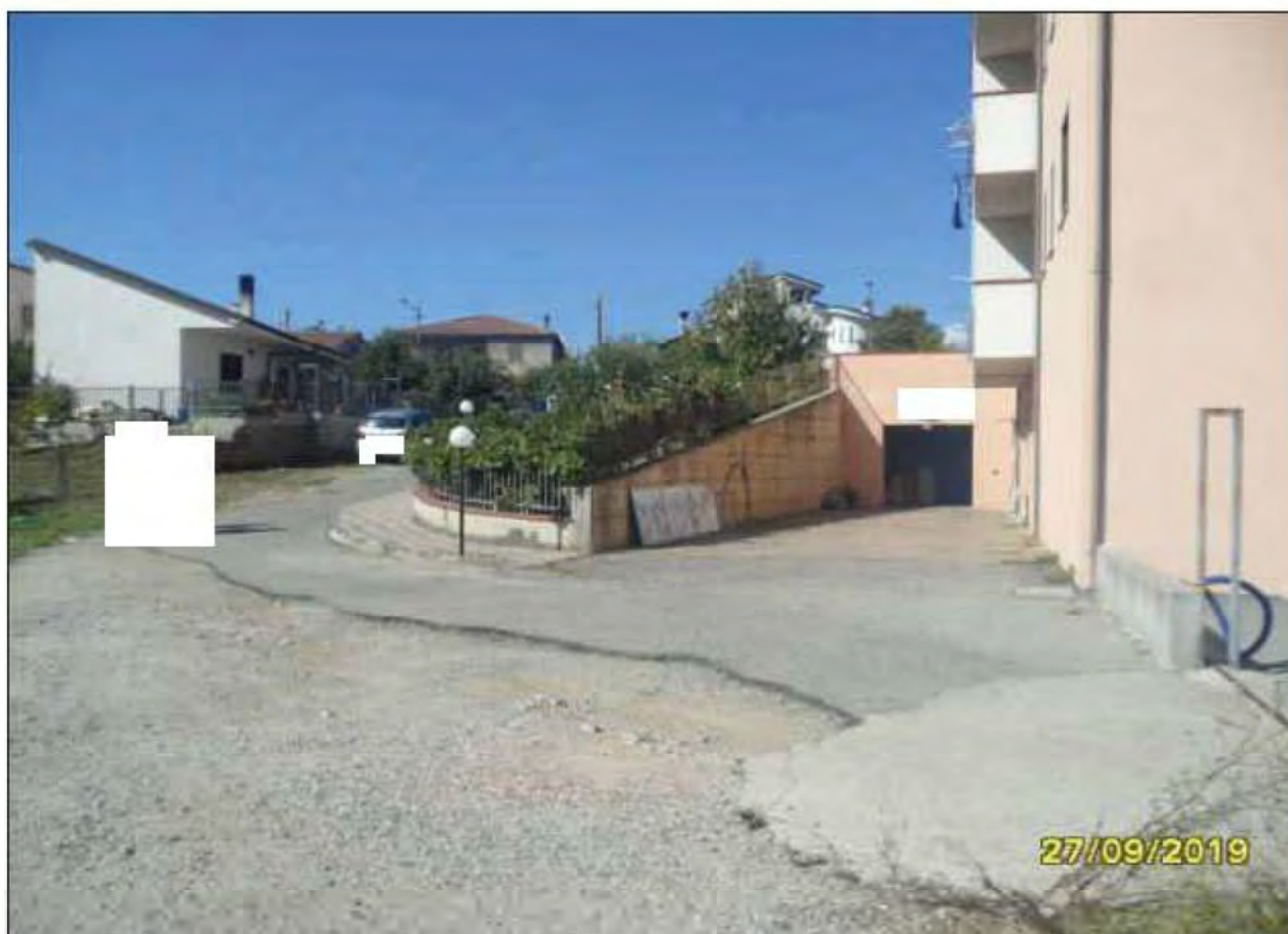
Fotografia n.34: Vista dell'area esterna condominiale all'abitazione, posta sul lato Sud-Est.
