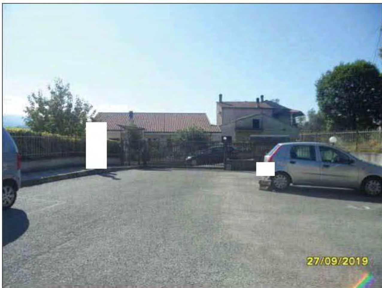
Fotografia n.29: Vista della corte esterna del fabbricato con evidenza del cancello, pedonale e carrabile, di accesso.
