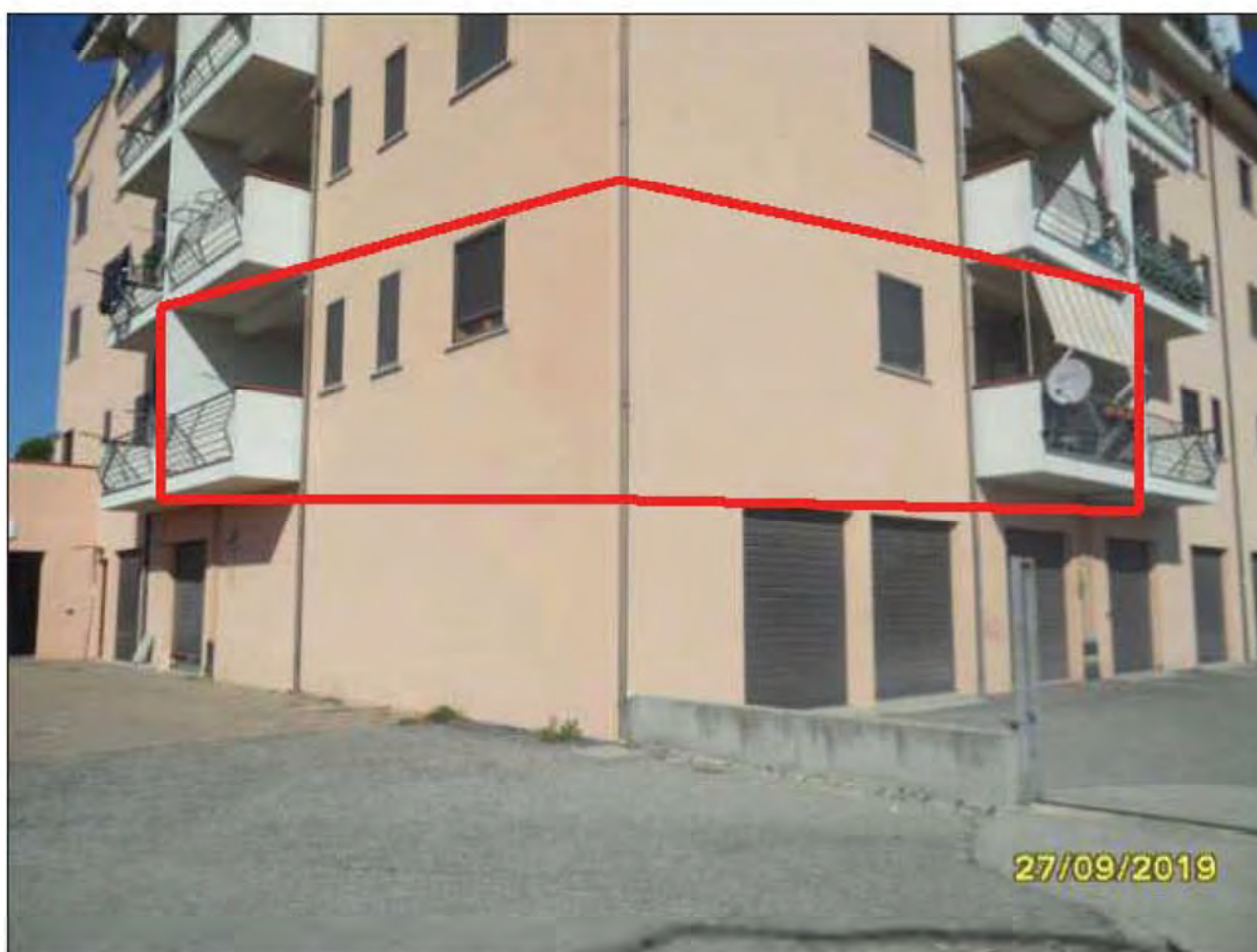
Fotografia n.32: Vista dell'abitazione da corte esterna: facciata attestata su lato Sud e sul lato Est.
