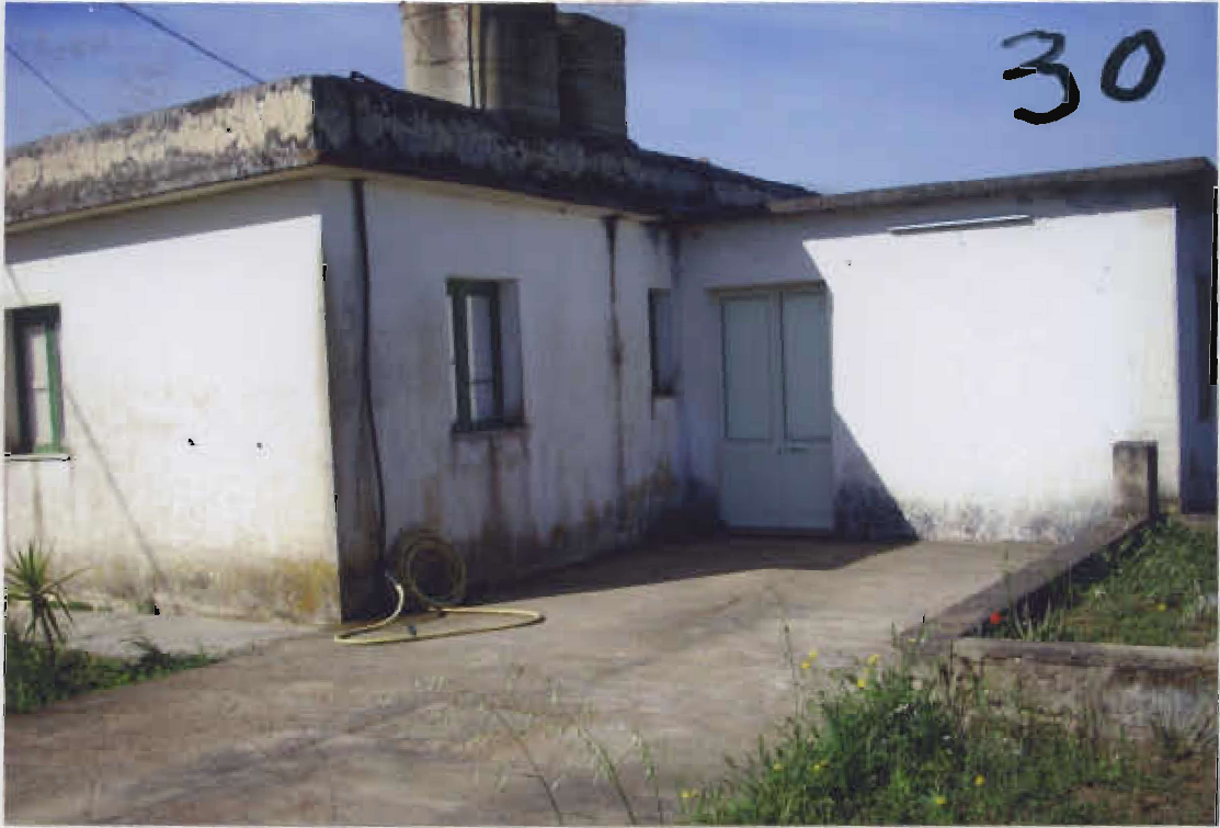
Prospetto sinistro del fabbricato
