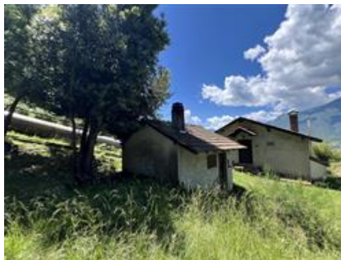
vista interna ed esterna dei mapp. 261 sub 1-2
