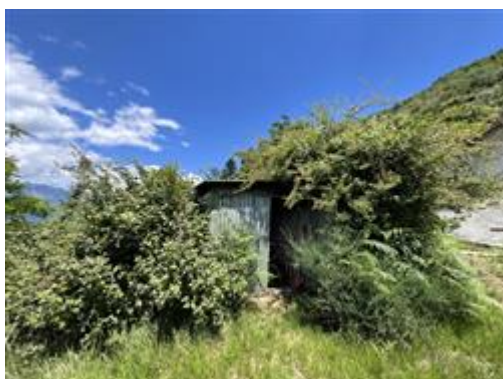
vista esterna del manufatto in lamiera
