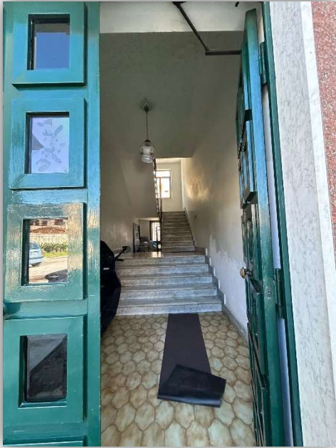
Portoncino di accesso al vano scala
