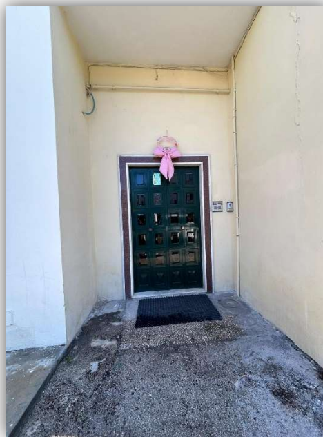
Portoncino di accesso al vano scala
