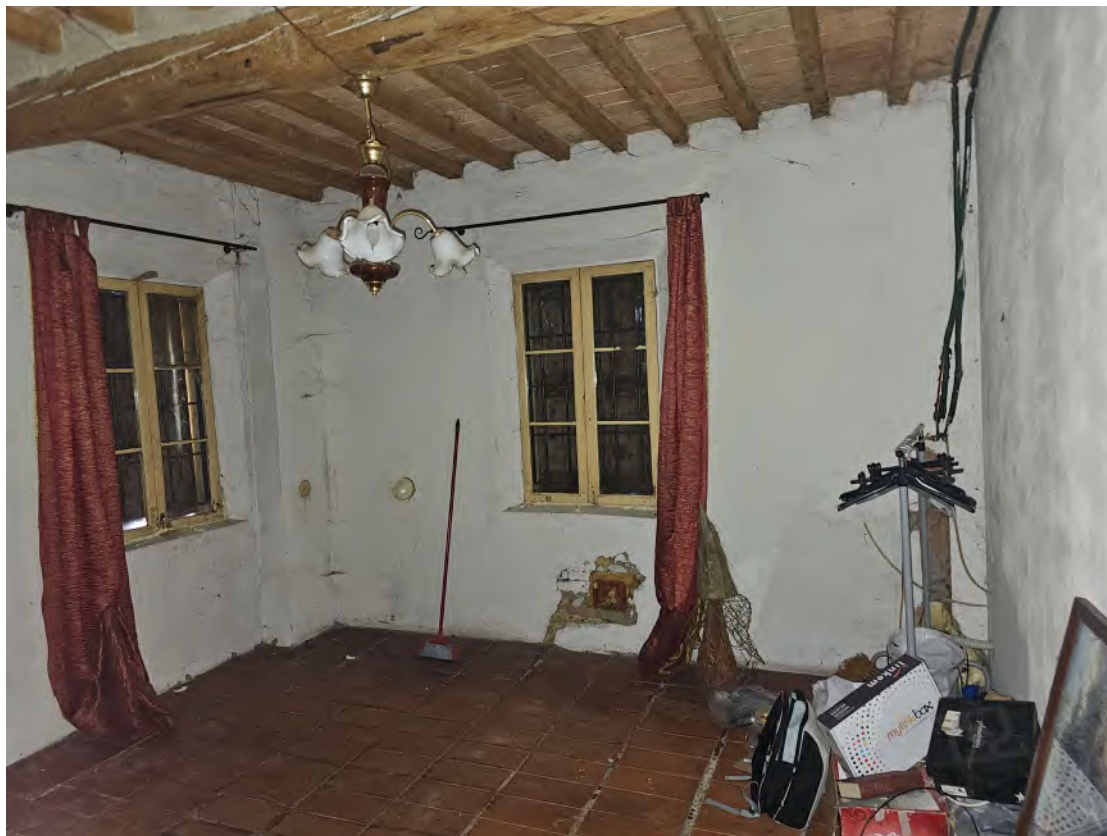
Interno 6: appartamento p.primo sub.14 – Soggiorno
