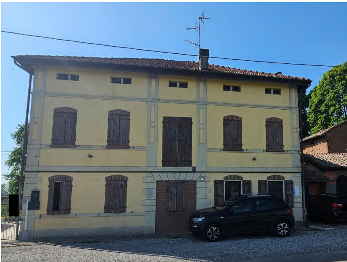
Esterno 2: Fabbricato abitativo map.84 – prospetto est
