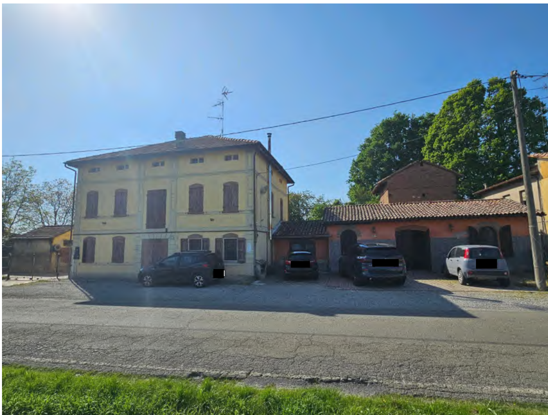
Esterno 1: Vista di insieme del complesso immobiliare – fronte est
