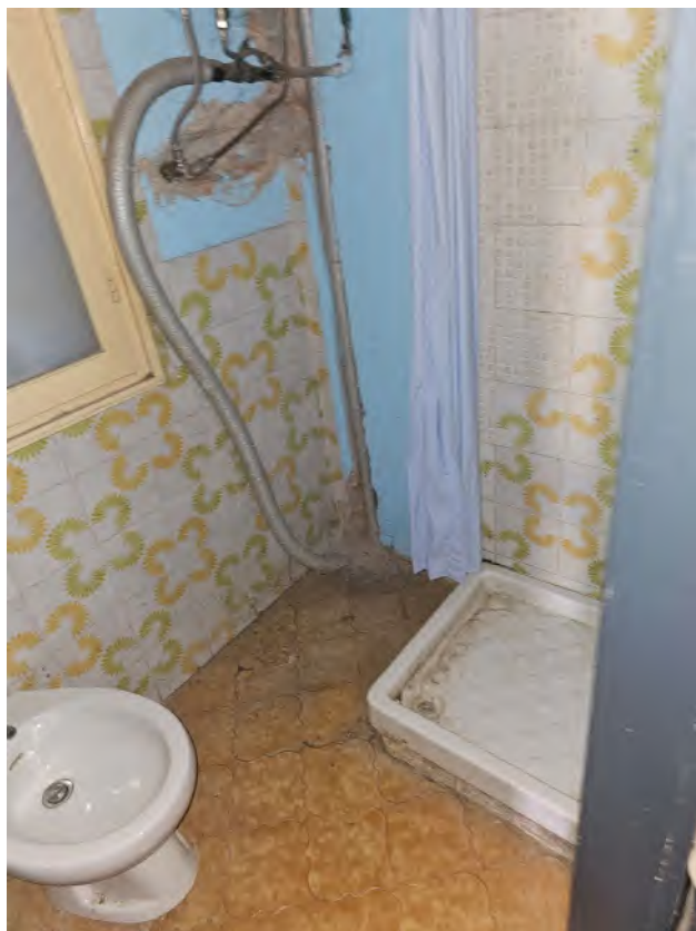
Interno 9: appartamento p.primo sub.14 – Bagno
