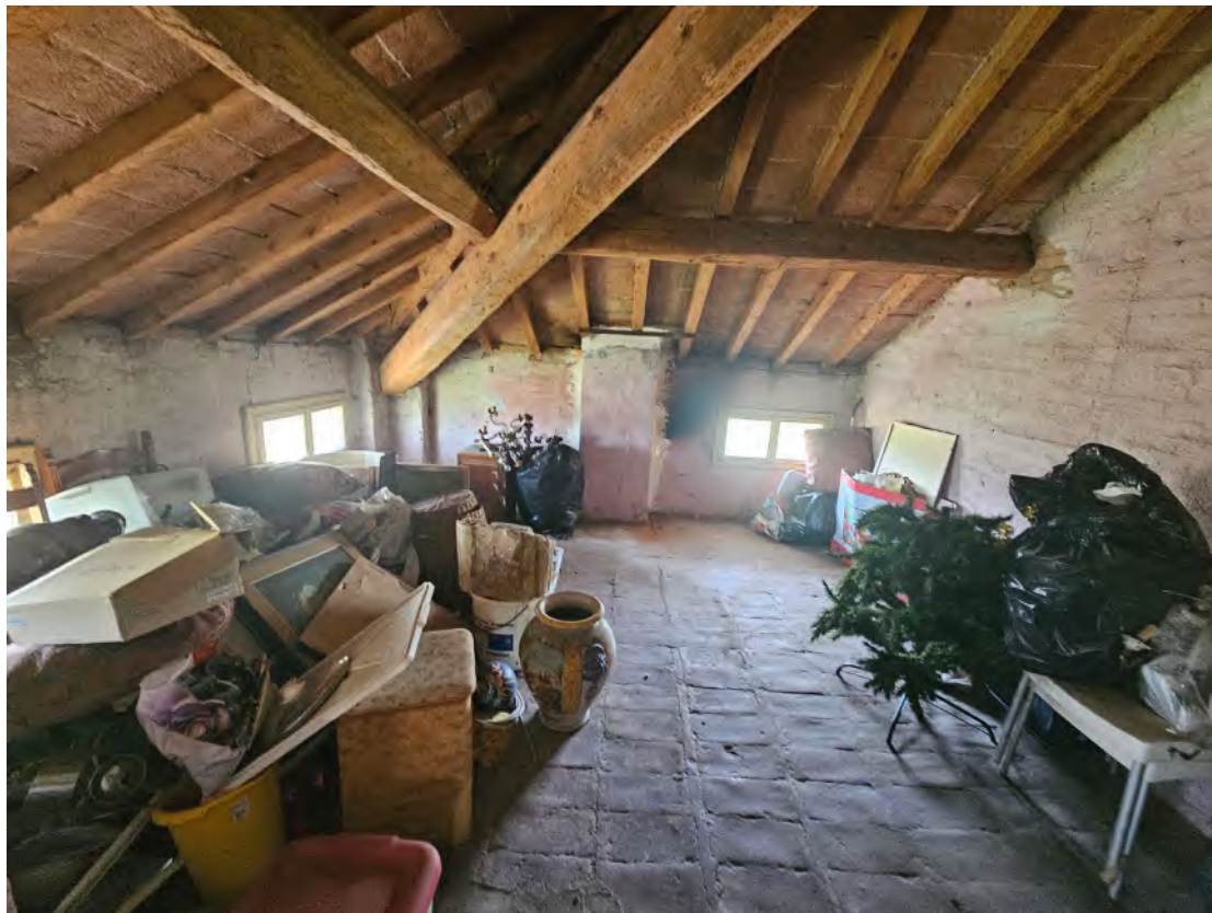
Interno 10: p.secondo – Soffitta
