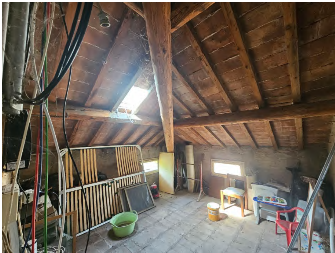
Interno 11: p.secondo – Soffitta
