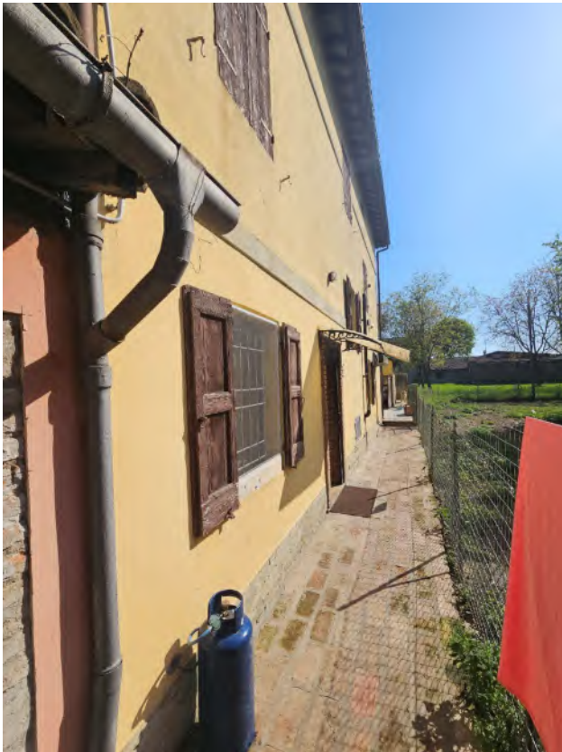
Esterno 4: Fabbricato abitativo map.84 – prospetto ovest
