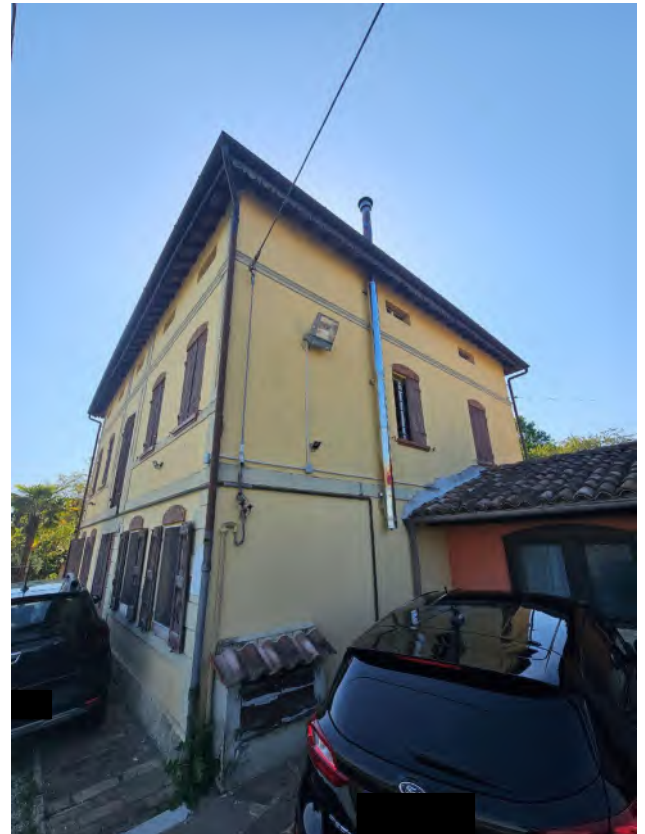
Esterno 5: Fabbricato abitativo map.84 – prospetto nord/est
