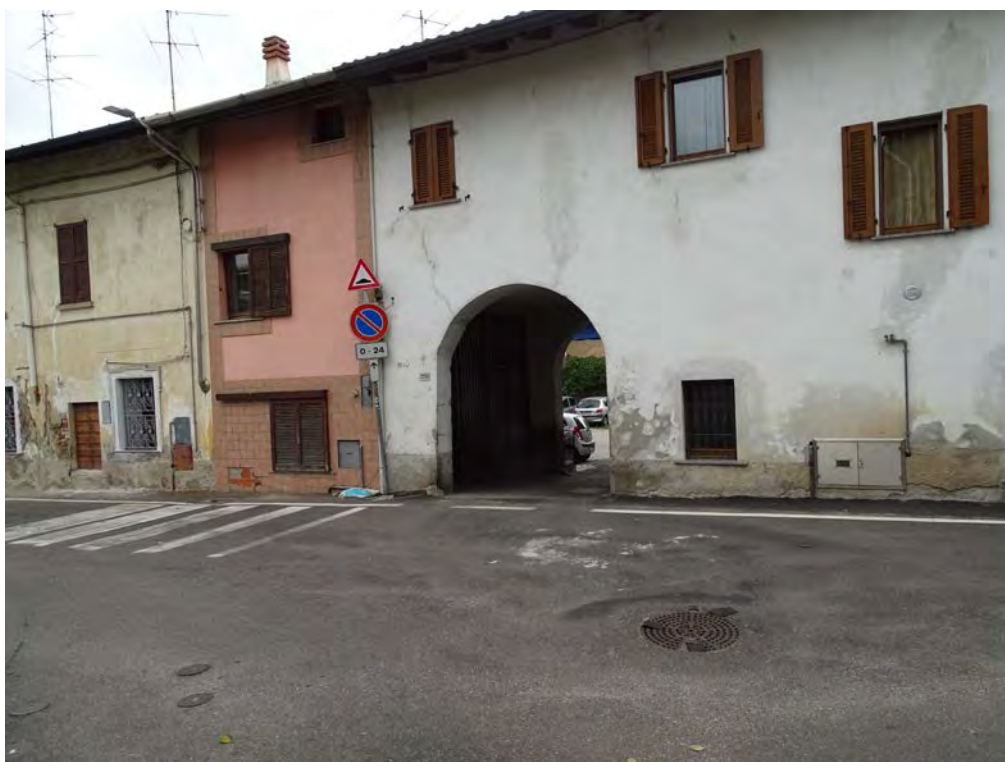
Vista ingresso carraio/pedonale da via IV Novembre
