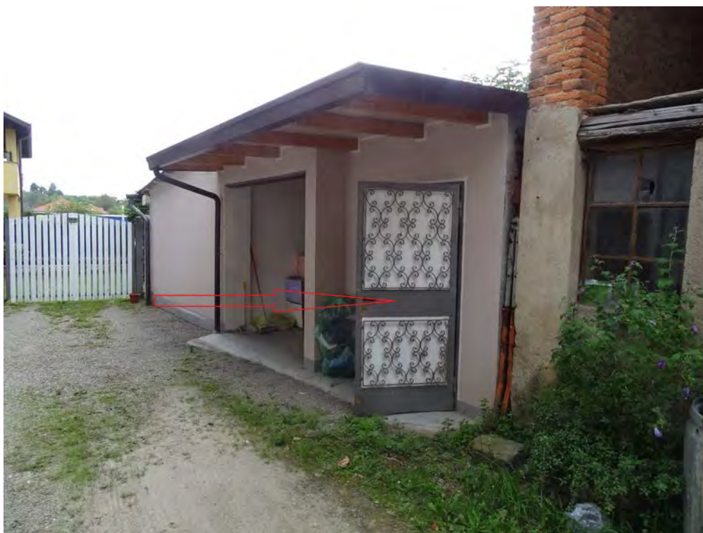
Vista ingresso ripostiglio dal cortile
