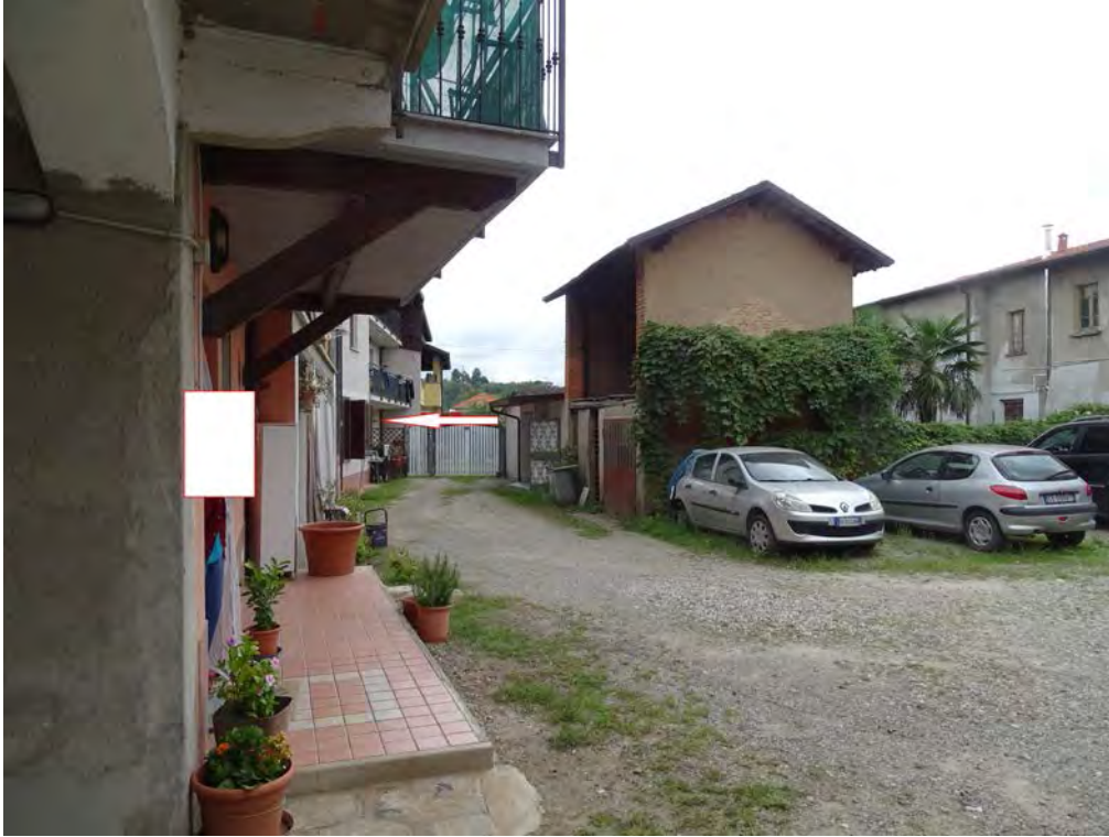
Vista interna cortile e posizione appartamento
