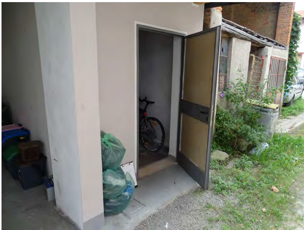
Vista ingresso ripostiglio dal cortile
