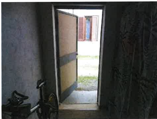
Vista interna ripostiglio
