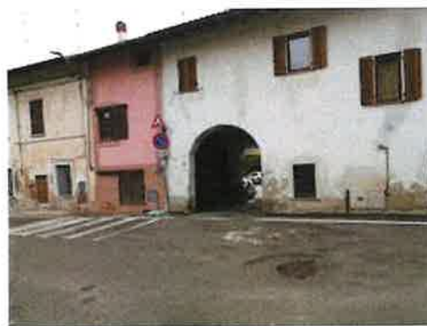
Vista passo carraio da via IV Novembre
