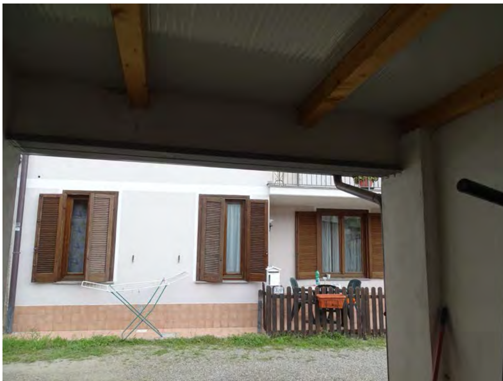
Vista box interna
