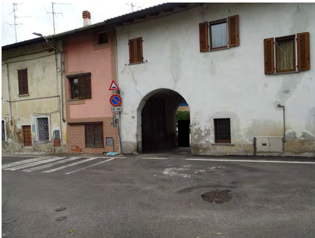
Vista ingresso carraio/pedonale da via IV Novembre
