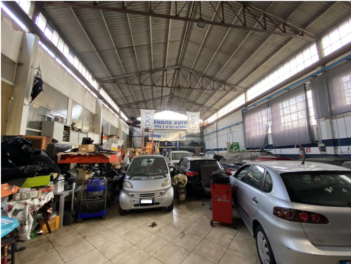
Fotografia 7 – Interno del capannone
