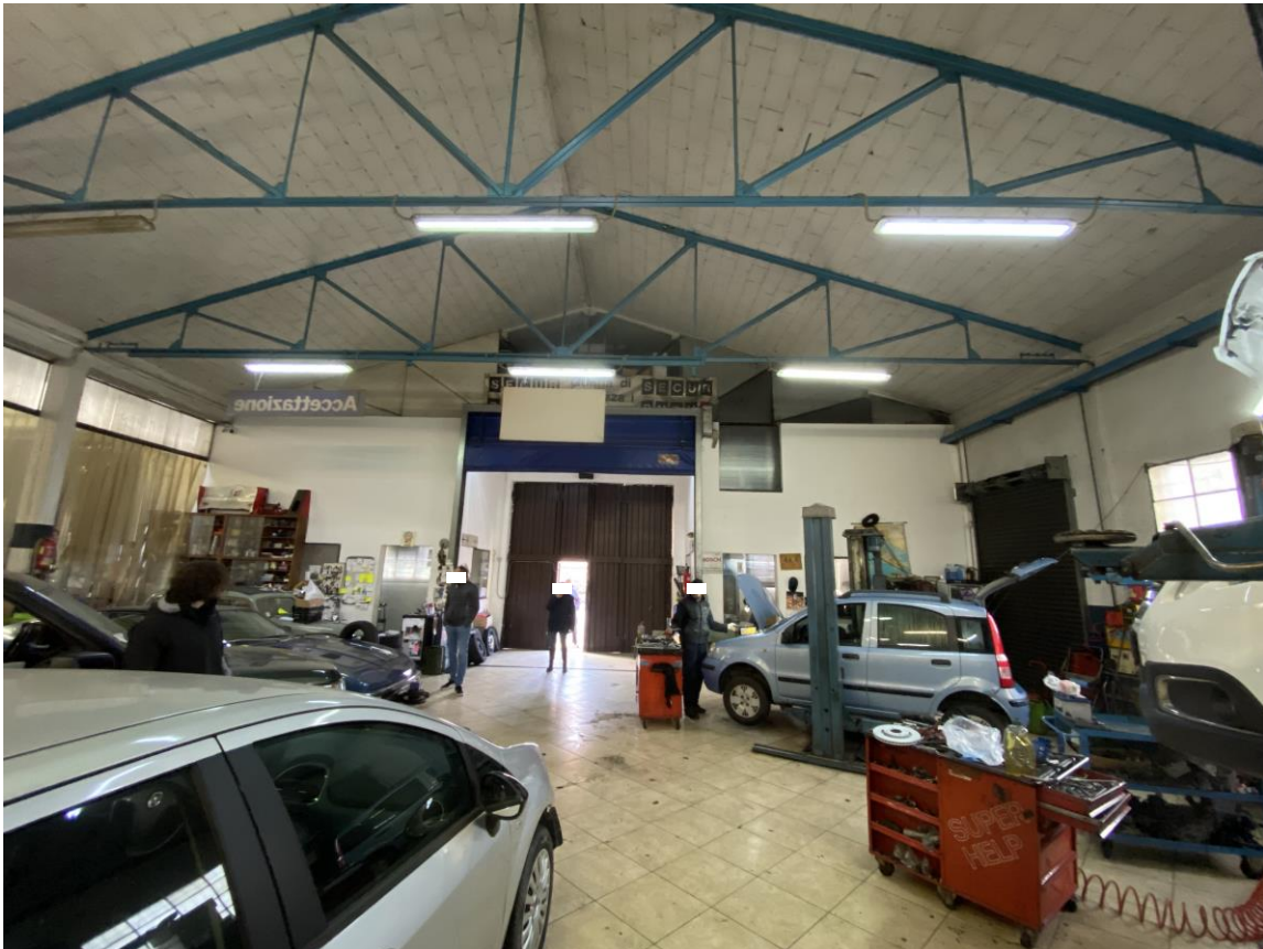
Fotografia 6 – Interno del capannone
