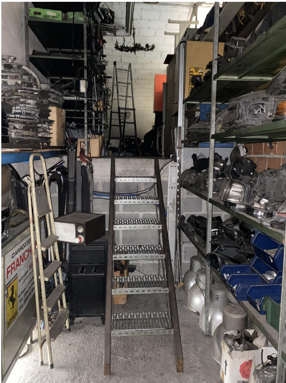
Fotografia 15 – Piano abusivo soprastante uffici
