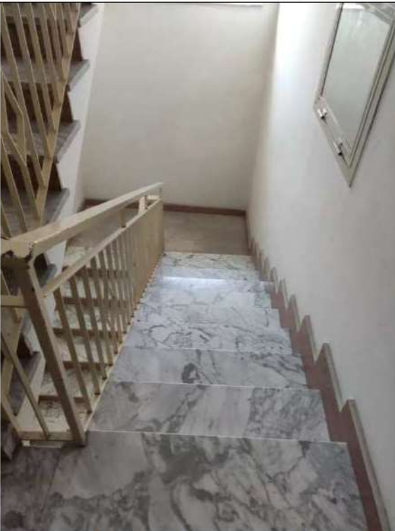
FOTO n. 8: Vista vano scala
