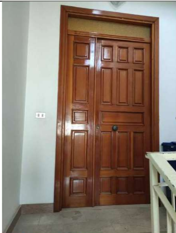
FOTO n. 9: Porta d'ingresso all'abitazione
