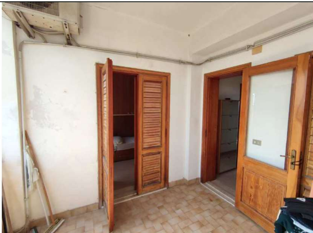
FOTO n. 35: Vista terrazza – particolare infissi esterni
