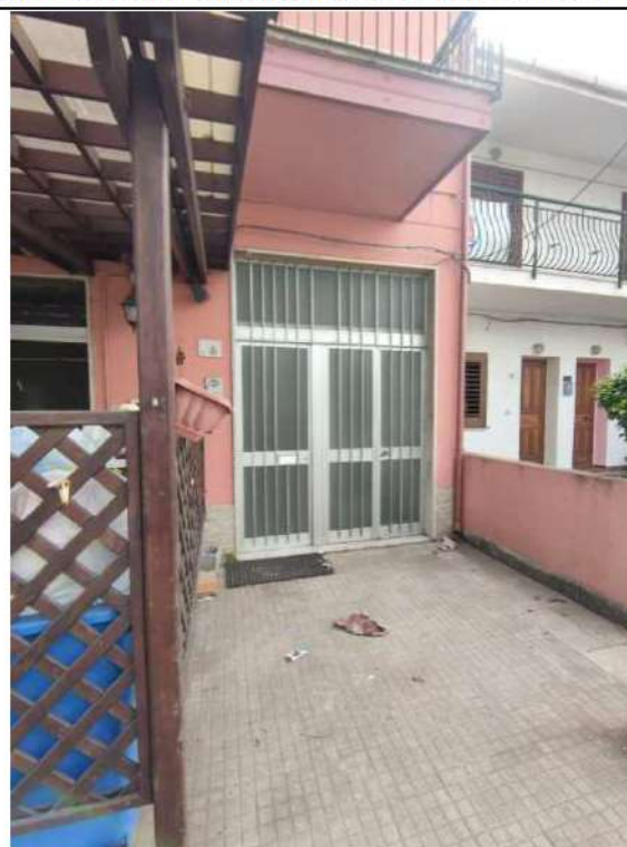
FOTO n. 5: Vista portone edificio con area cortilizia
