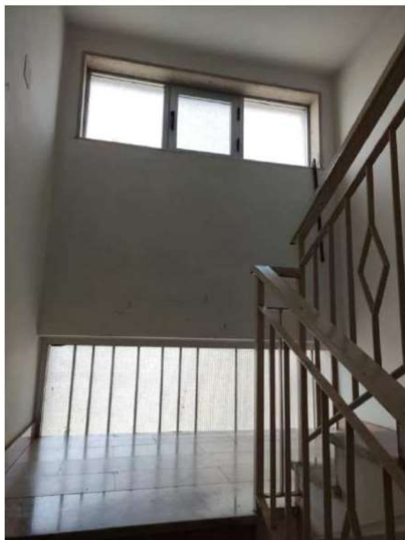
FOTO n. 7: Vista vano scala
