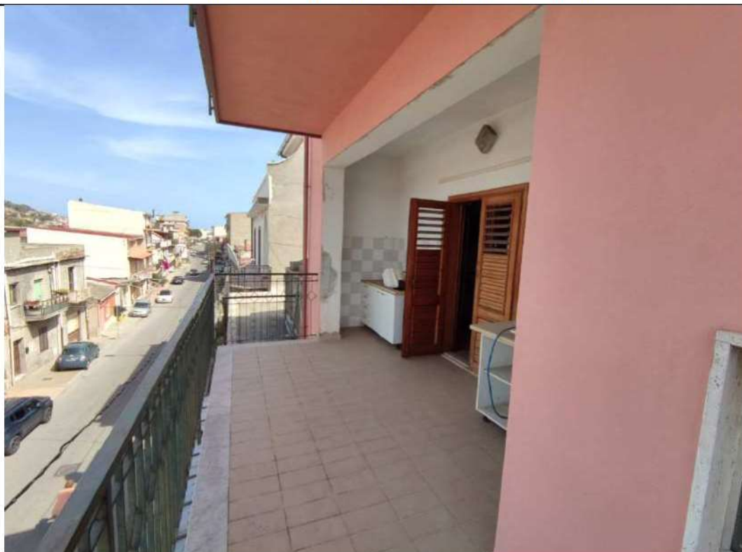
FOTO n. 33: Vista balcone con affaccio sulla via Lembo
