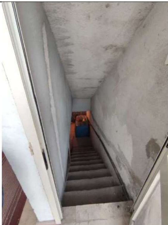
FOTO n. 47: Vista scale piano interrato
