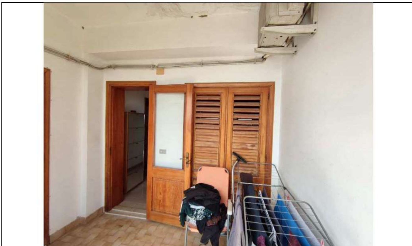
FOTO n. 36: Vista terrazza – particolare infissi esterni
