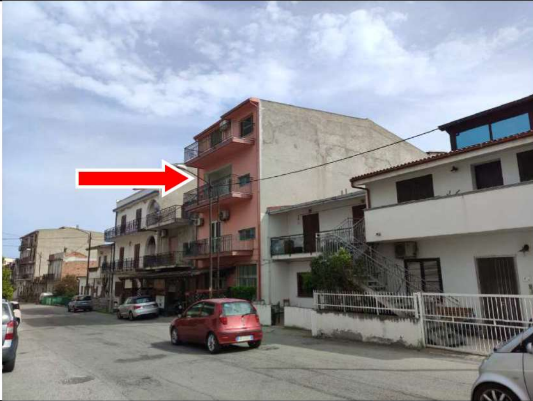
FOTO n. 1: Vista esterna fabbricato dalla via Lembo
