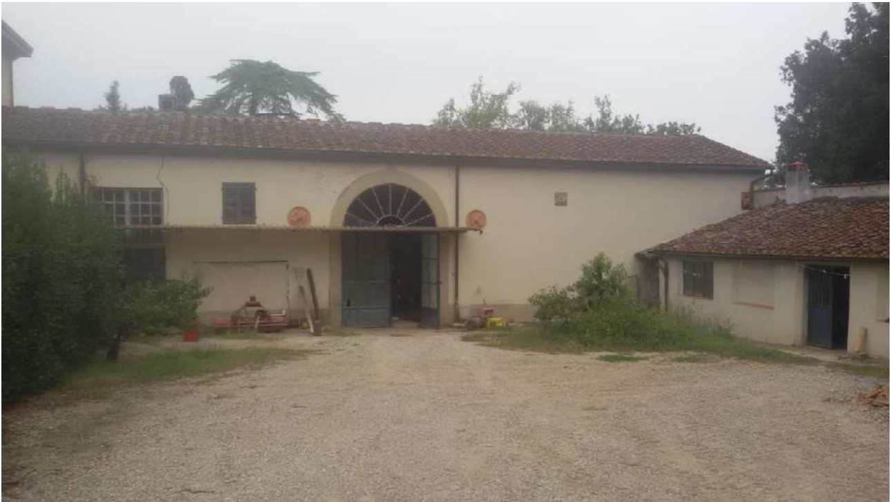
Annesso ad uso magazzino-Prospetto principale (F. 47 part.161 sub.2)
