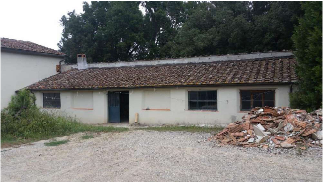
Annesso ad uso magazzino-Prospetto laterale (F. 47 part.161 sub.2)
