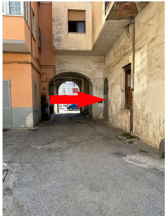
Vista accesso alla casa scale
