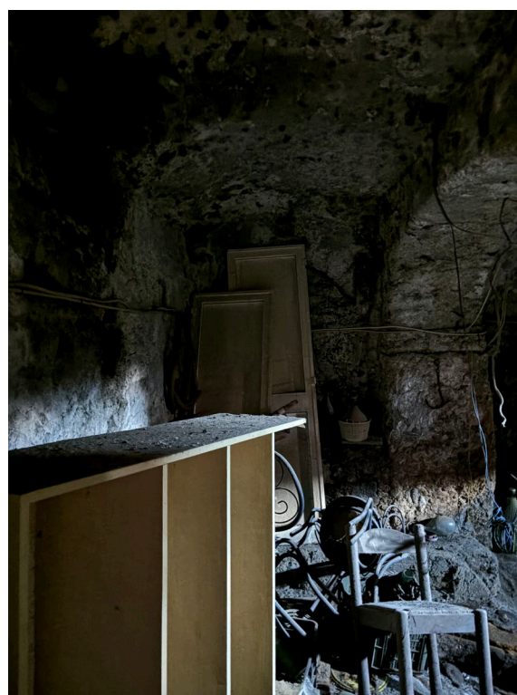
Vista locale di proprietà - deposito
