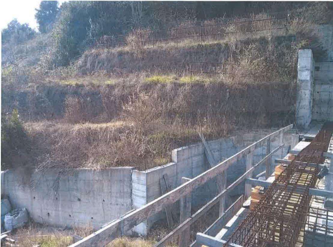
**Foto 17- terre armate a lato dell'arrivo della rampa di accesso all'edificio**
