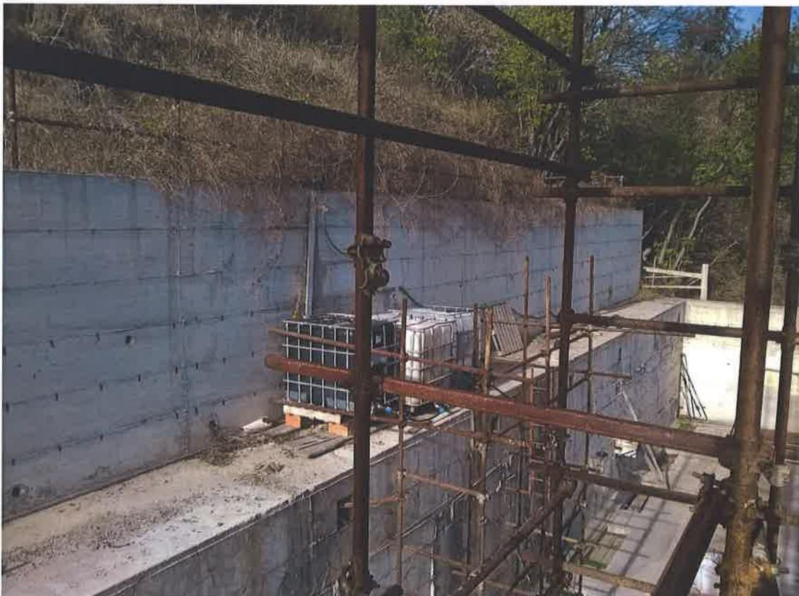
**Foto 12- muro lato monte angolo nord-ovest con terre armate soprastanti**
