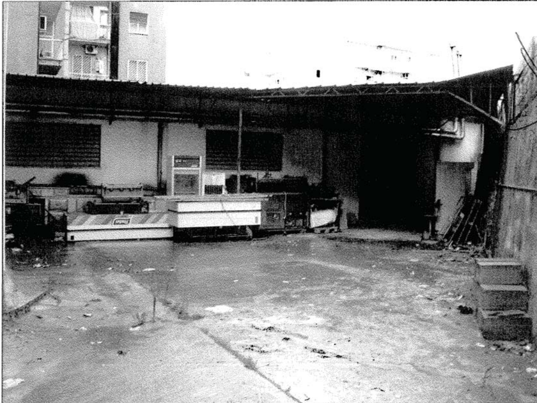
Foto 4 – Vista esterna delle unità immobiliari costituenti il lotto n. 2. Fg 3 part. 138 subb 12, 13 e 14 - Corte
