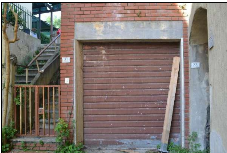
1. Scala d'ingresso e garage al piano terra
