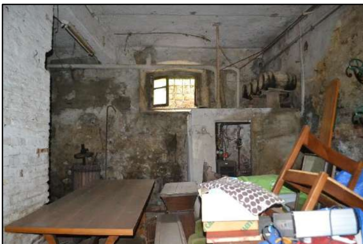
27. Interno cantina al piano terra
