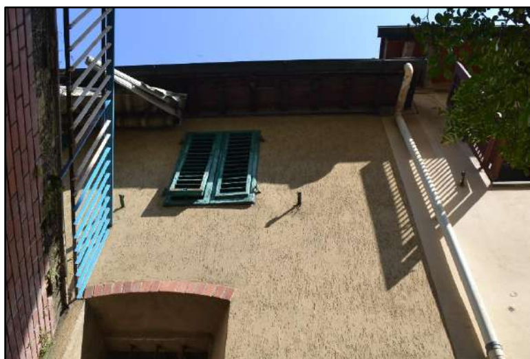
4 .Facciata sopra il passaggio a comune al piano terra
