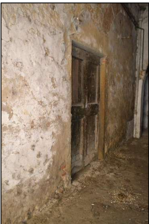
3. Porta d'ingresso cantina al piano terra
