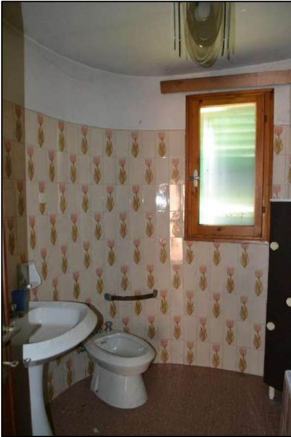
23. Bagno al primo piano
