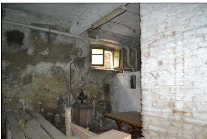
29. Interno cantina al piano terra
