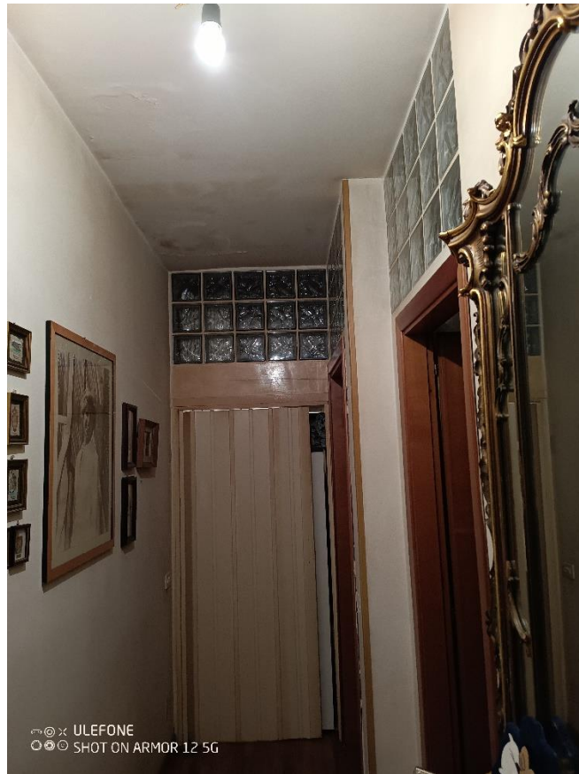
Foto 7 : Corridoio con vista del ripostiglio
