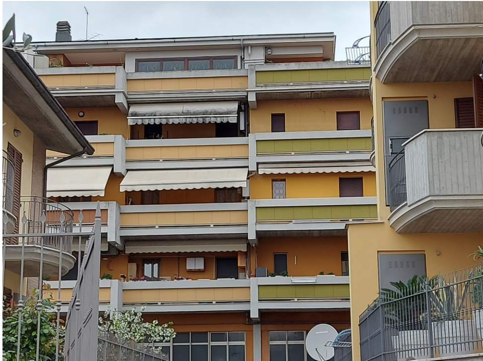
FOTO DEL FABBRICATO DA NORD
