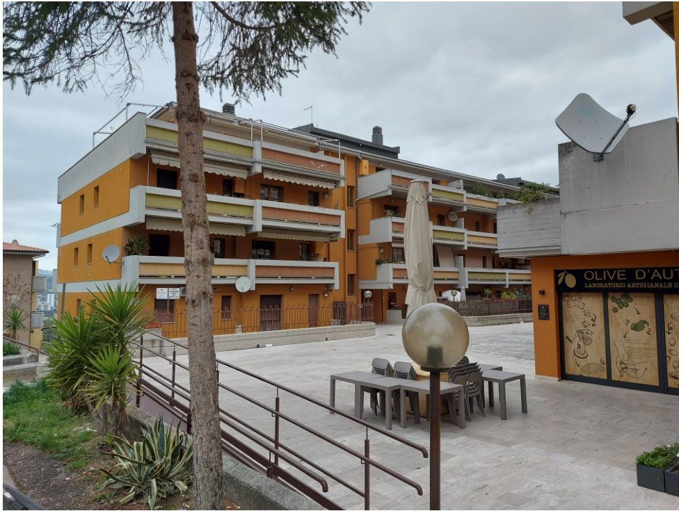
FOTO DEL FABBRICATO DAL PIAZZALE ANTISTANTE A SUD
