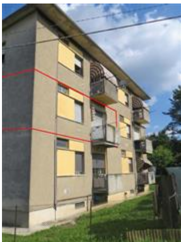
L'affaccio Ovest della palazzina (in rosso l'unità in oggetto)
