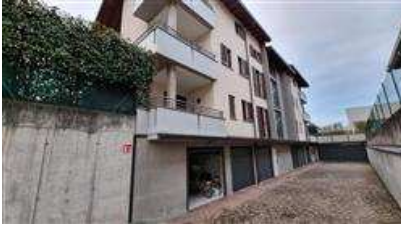
rampa ingresso carraio e prospetto posteriore
