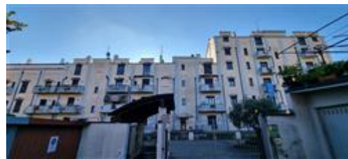
Vista dell'edificio condominiale
