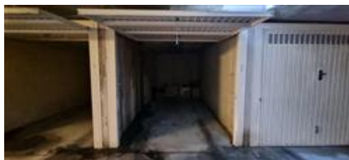
Vista dell'accesso al locale autorimessa
