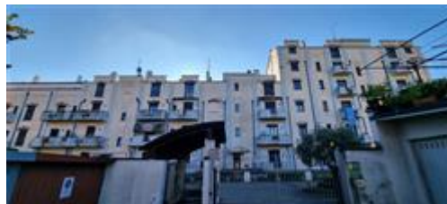
Vista dell'edificio condominiale
