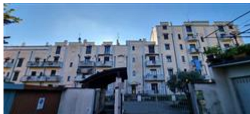
Vista dell'edificio condominiale
