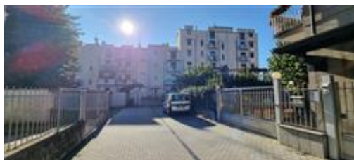
Vista del corsello di accesso all'edificio condominiale
