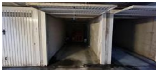
Vista dell'accesso al locale autorimessa
