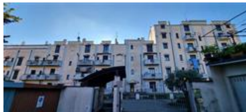
Vista dell'edificio condominiale
