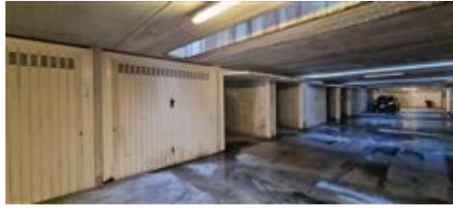
Vista del corsello comune e dell'accesso al box
