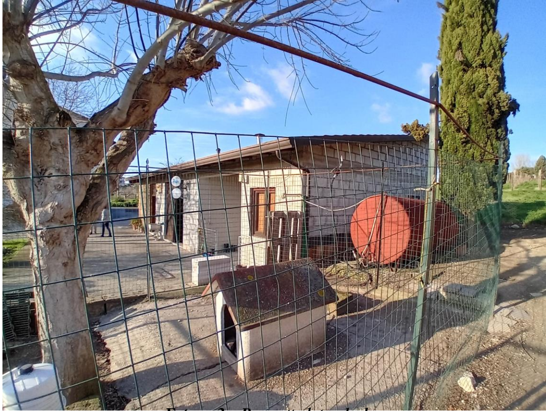
Foto n. 3__ Prospetto laterale dx
