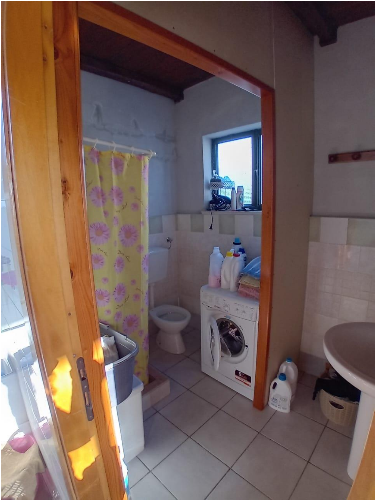
Foto n. 9__Wc (Foglio 17 p.lla 2176 sub 3)
