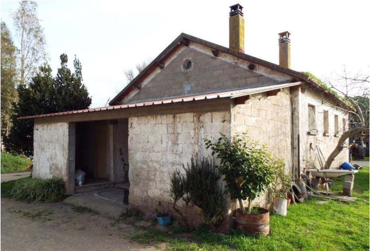
Figura n. 20: ex stalla - prospetto nord
