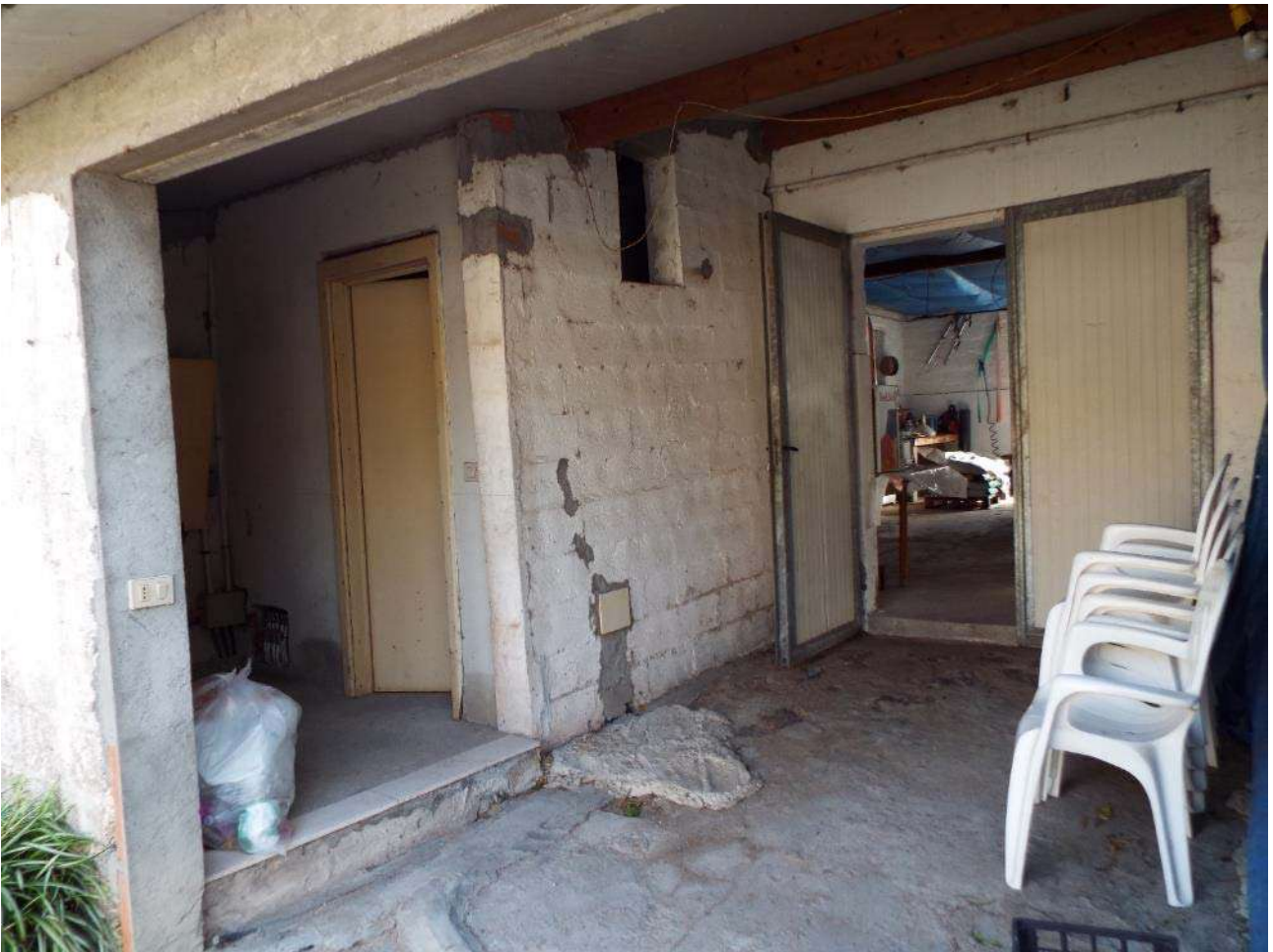
Figura n. 23: ex stalla sgombero con area rialzata di ingresso al bagno
