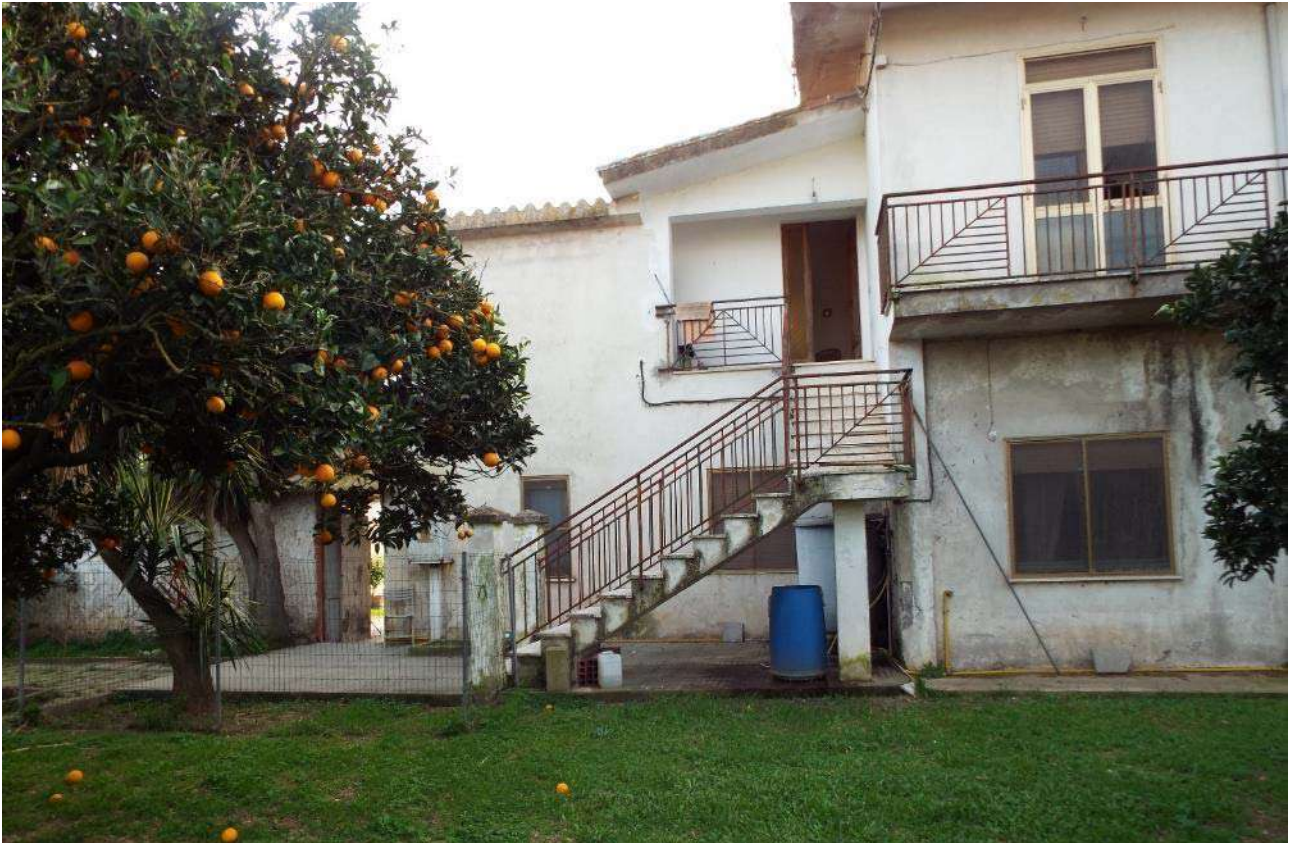
Figura n. 2: casa colonica - prospetto nord
