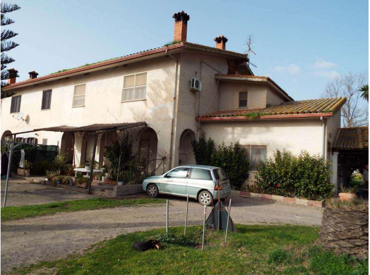
Figura n. 1: casa colonica - prospetto sud
