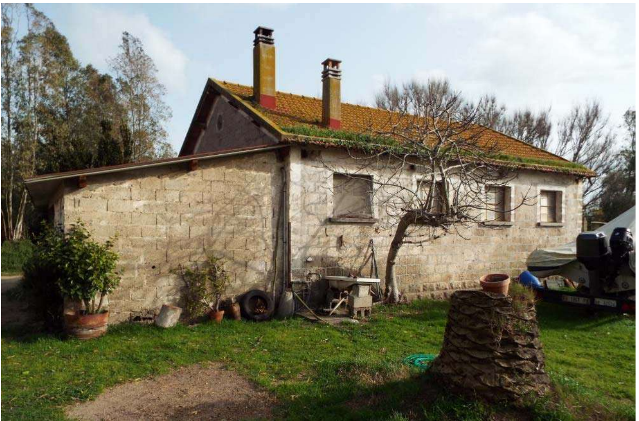
Figura n. 21: ex stalla prospetto ovest
