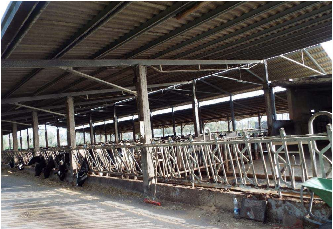
Figura n. 32: vista interna della stalla
