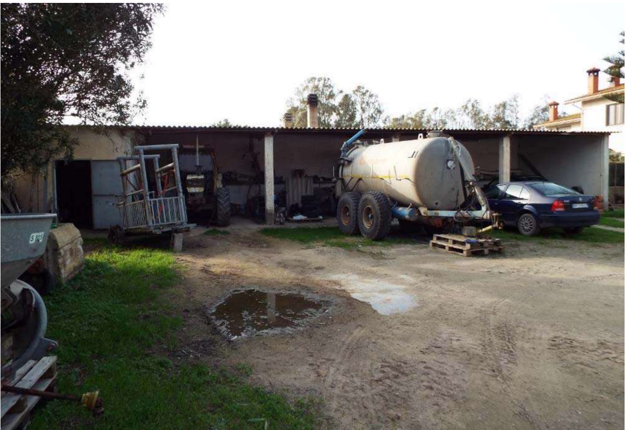
Figura n. 27: tettoia ricovero mezzi e attrezzi
