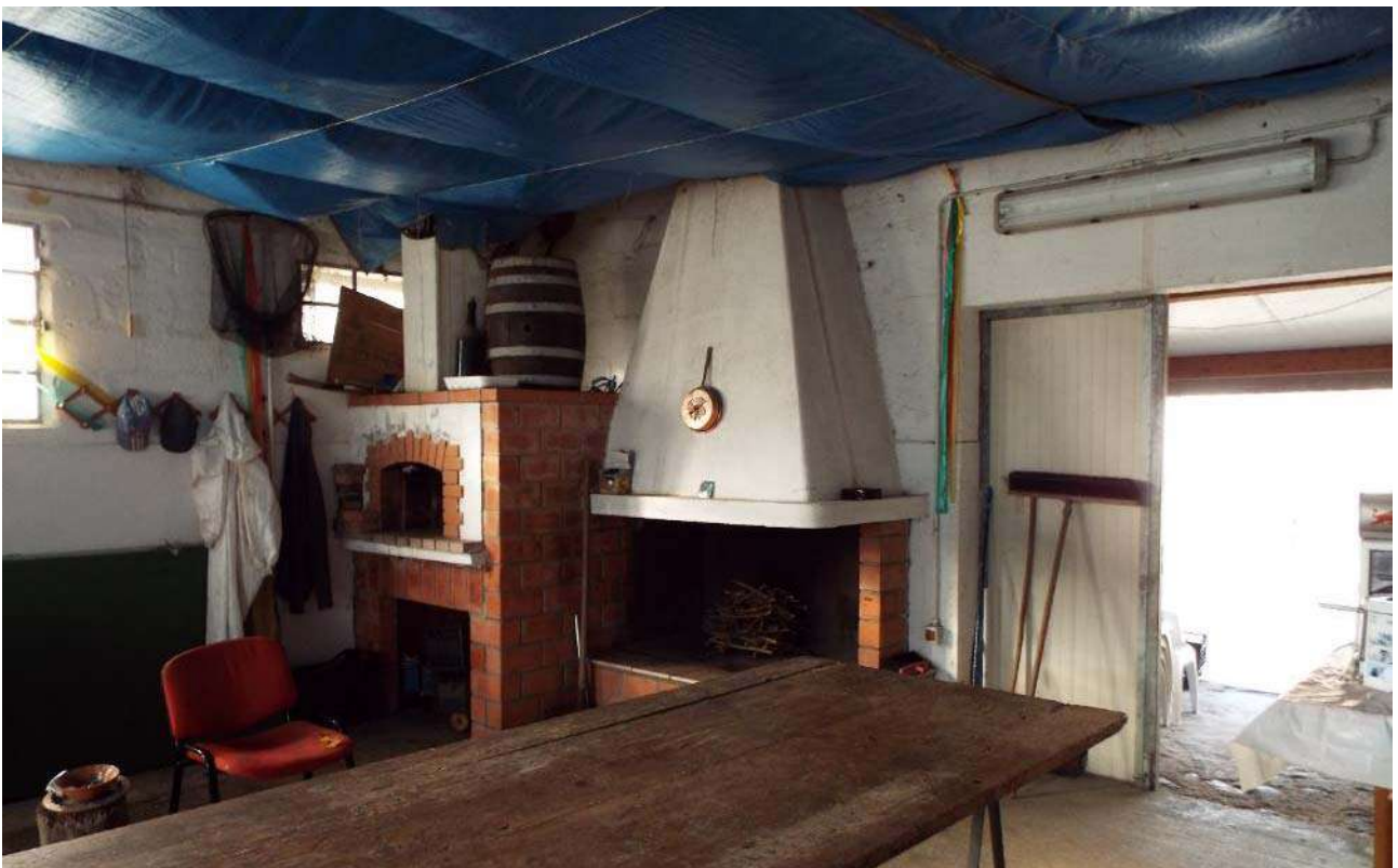
Figura n. 25: ex stalla - locale di sgombero
