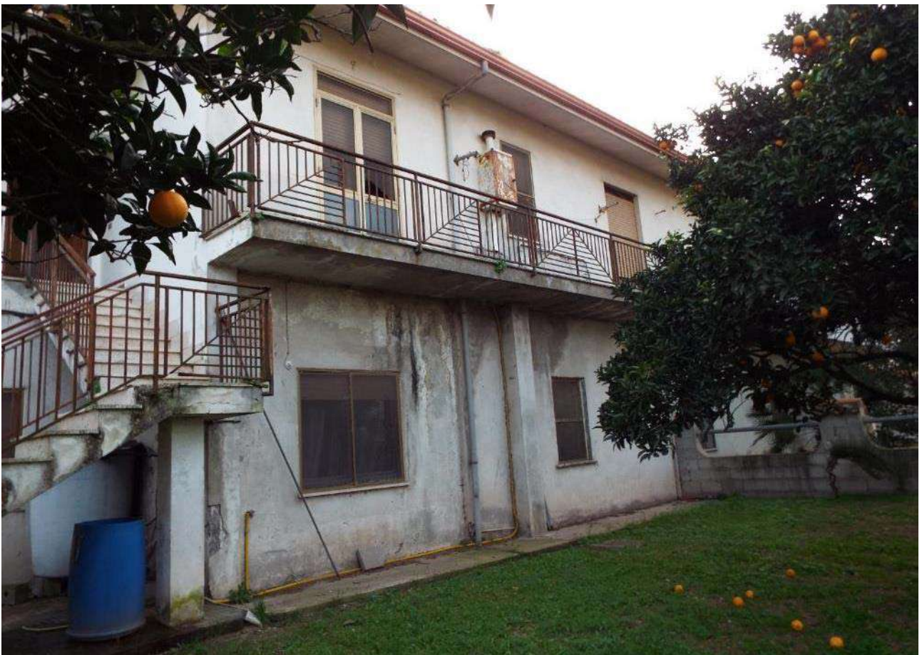
Figura n. 3: casa colonica - prospetto nord
