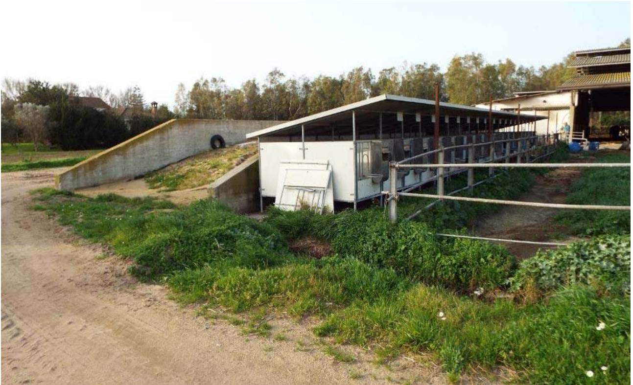
Figura n. 39: tettoia con 20 gabbotti di alimentazione vitellini
