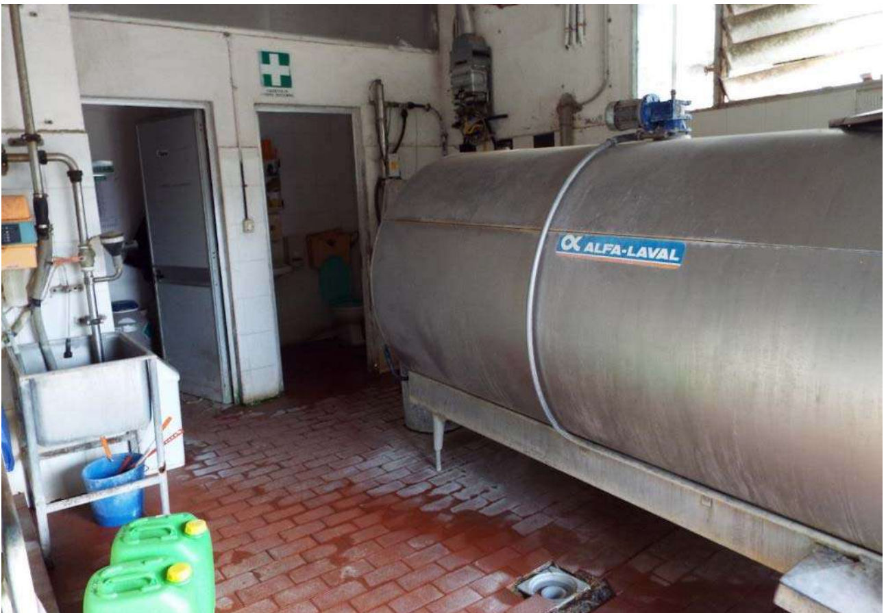
Figura n. 35: cisterna del latte, locale ufficio e bagno
