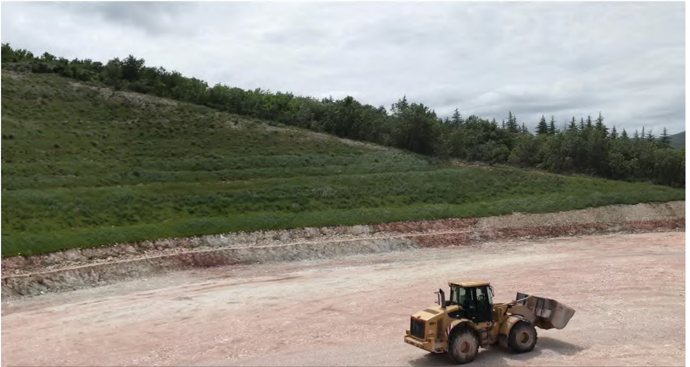
Fig. 6 – Vista del lato W della scarpata finale di cava (Ambito 2) e del piazzale di coltivazione
