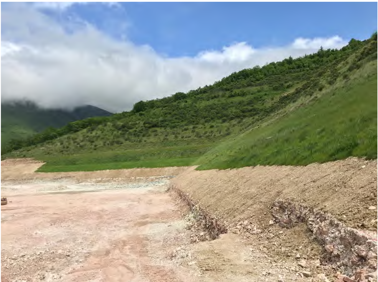
Fig. 5 - Vista del piazzale in coltivazione (Ambito 2), della scarpata finale (E – SE) rinverdata e degli ultimi due microgradoni, riempiti di sterili di coltivazione e terreno vegetale, pronti per l'intervento di idrosemina nella stagione adeguata
