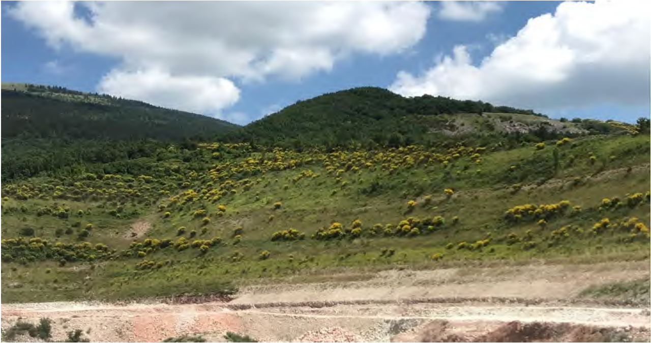
Fig. 4 – Vista della scarpata finale di cava (Ambito 2) già coltivata e (quasi completamente) recuperata
