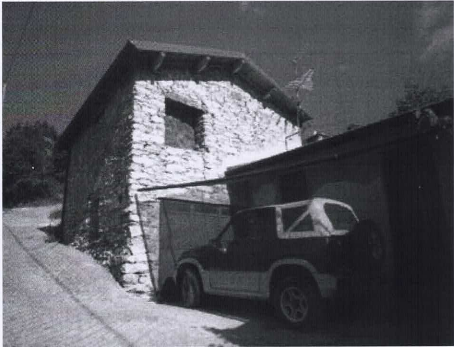
Fabbricato 2 ingresso piano S1
