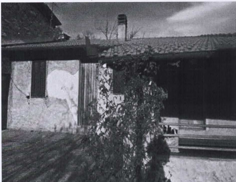
Fabbricato 1 visto da sud
