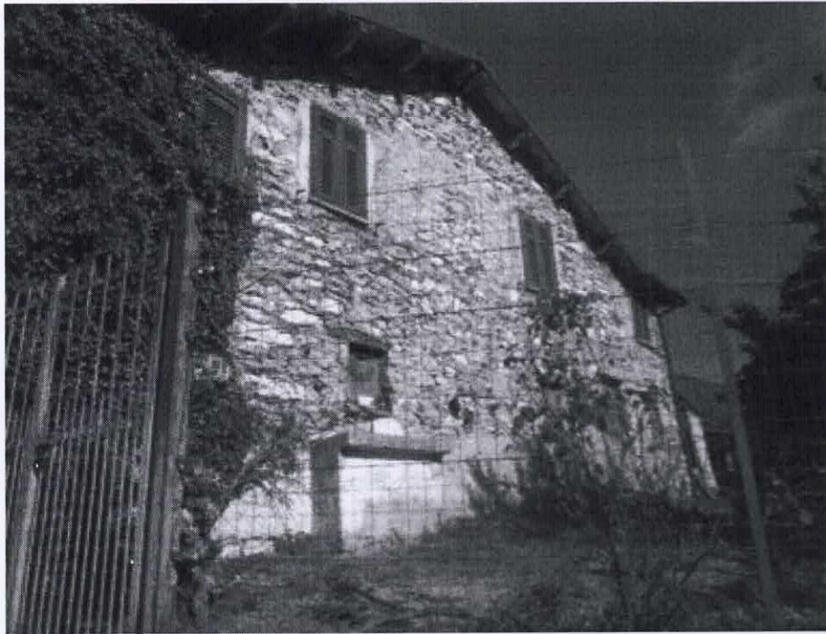
Fabbricato 1 visto da est
