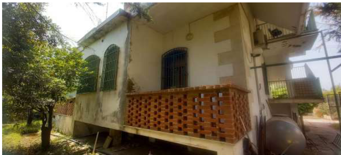
Foto 10 – Immobile “1A” – Prospetto Nord
