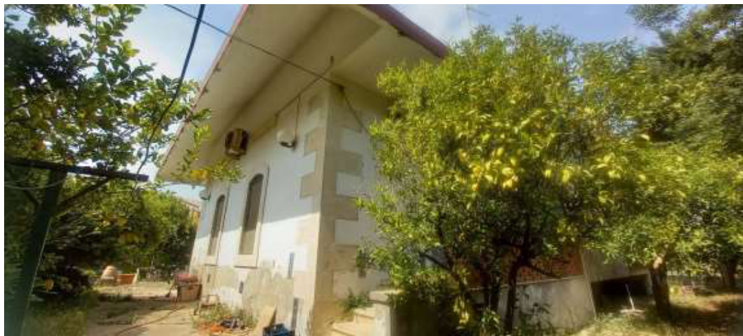
Foto 8 – Immobile “1A” – Prospetto Est
