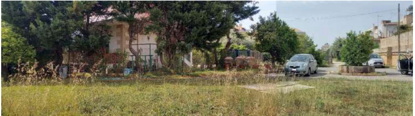
Foto 1 – Immobile “1A” – Veduta dell’accesso principale al lotto di terreno
