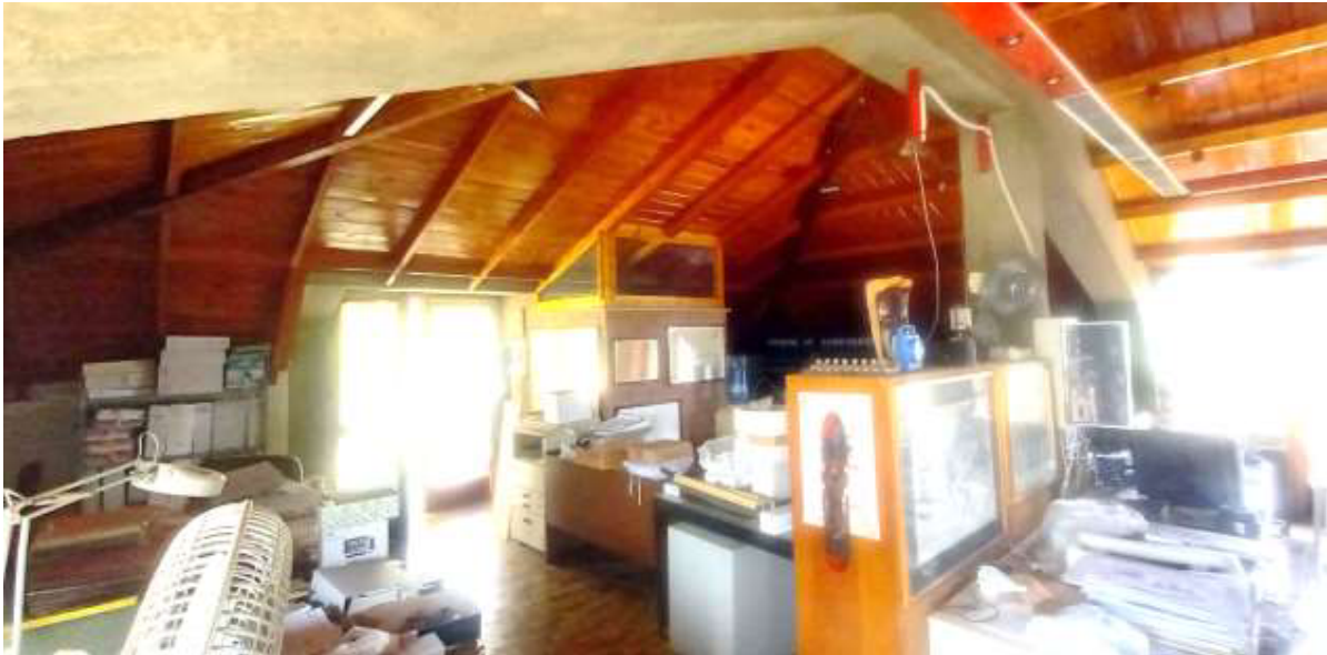
Foto 31 – Immobile “1A” – Locale sottotetto al I P
