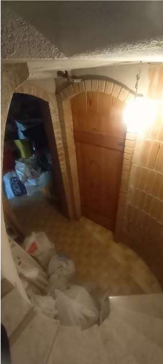
Foto 29 – Immobile “1A” – Piano seminterrato
