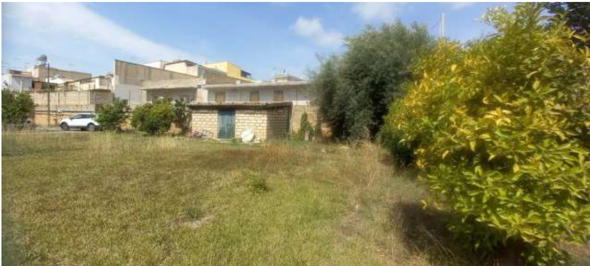
Foto 14 – Immobile “1A” – Locale “deposito”
