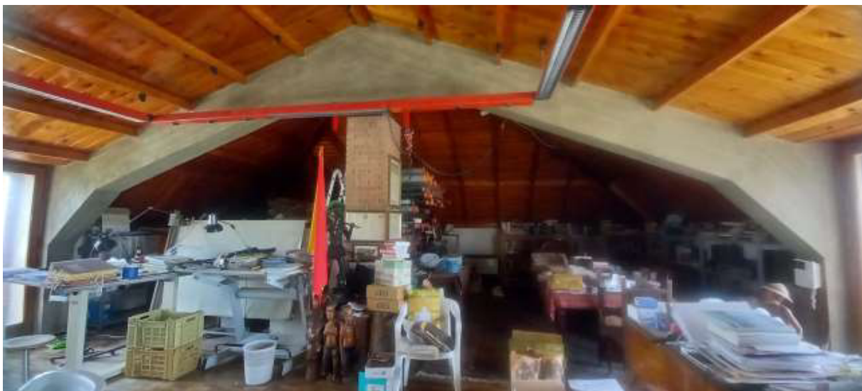
Foto 32 – Immobile “1A” – Locale sottotetto al I P
