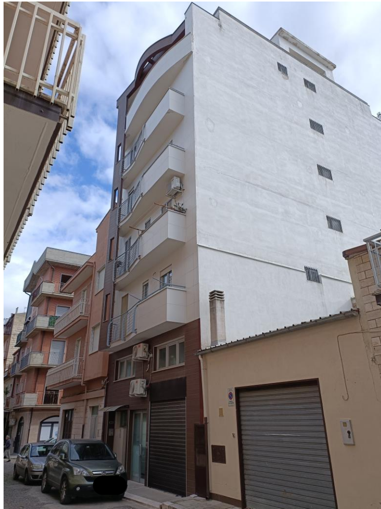
Figura 1 – Panoramica Condominio Via Micaeli, n. 43, Lavello (PZ).
