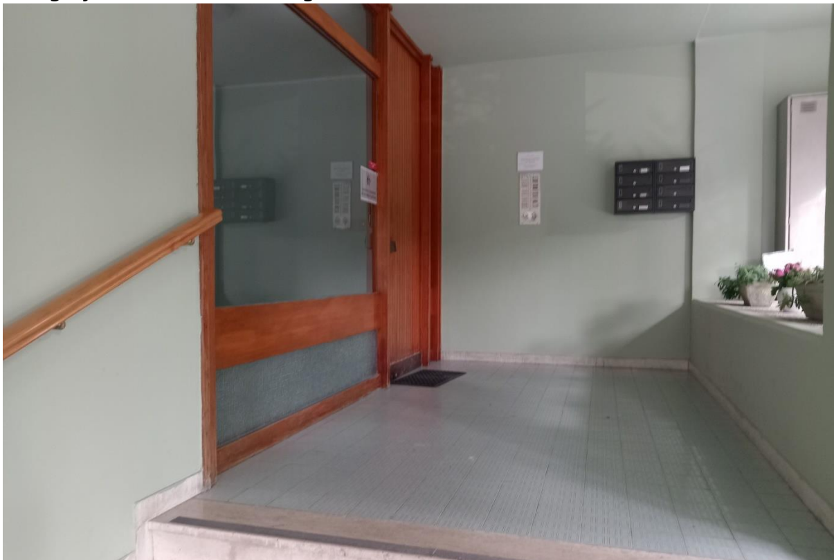
Fotografia n. 3 – Vista dell'ingresso condominiale
