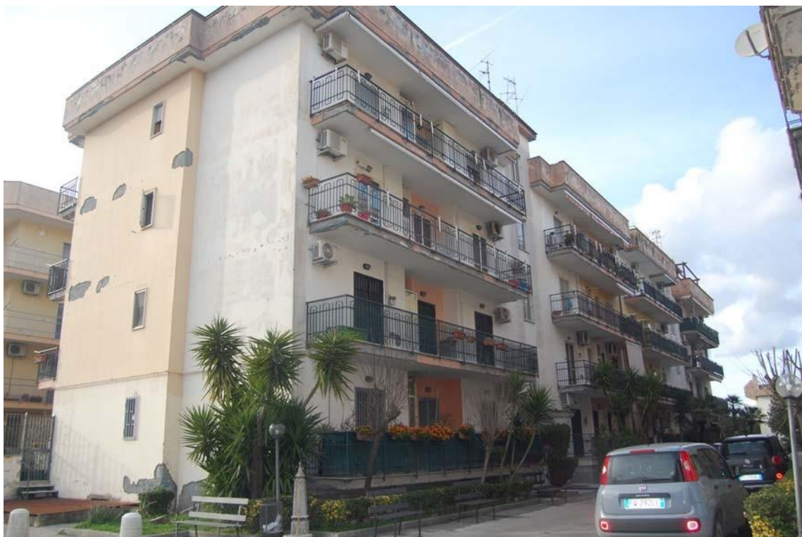
Foto edificio B scala A.
