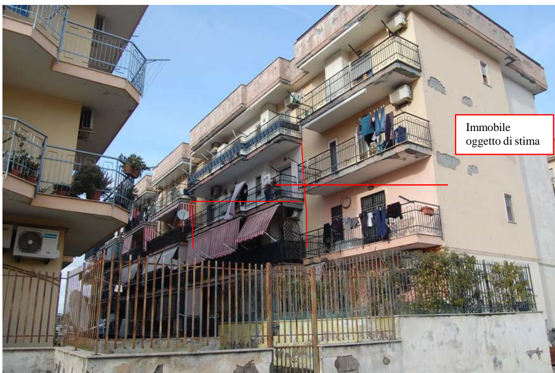
Foto edificio B scala A.
