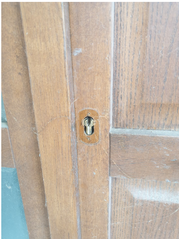
FOTOGRAFIA N. 3 – SERRATURA DELLA PORTA DI ACCESSO DELL'IMMOBILE
