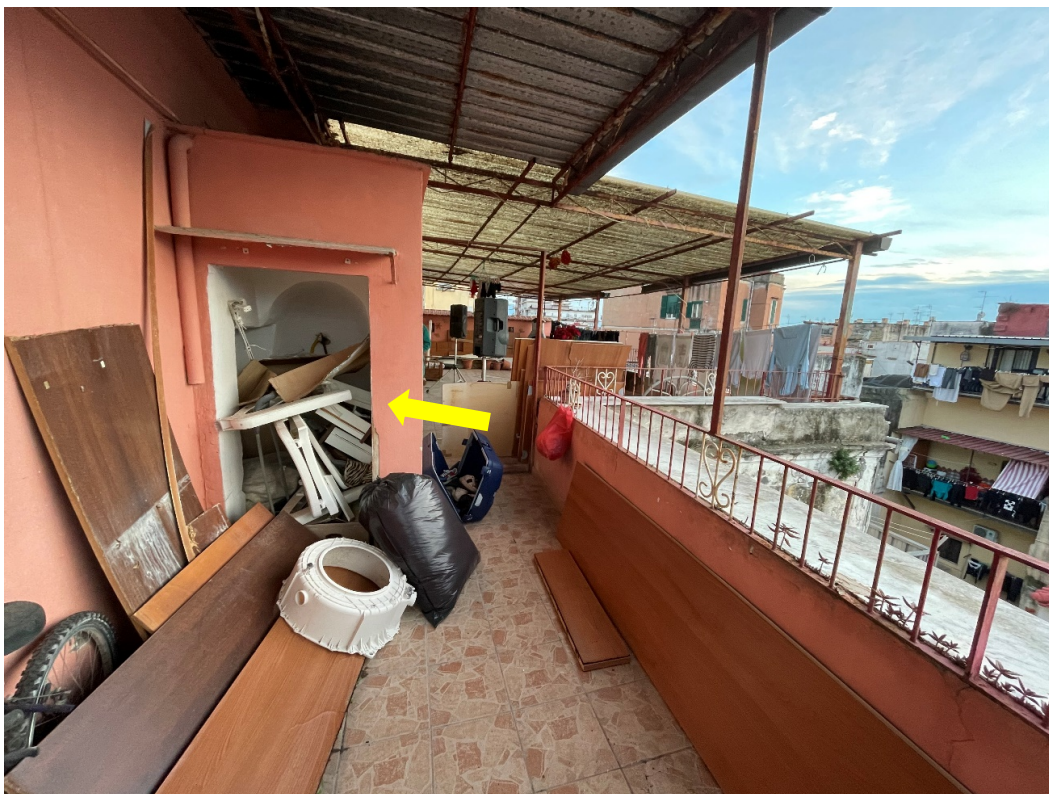
Secondo ripostiglio con accesso dal terrazzo a livello
