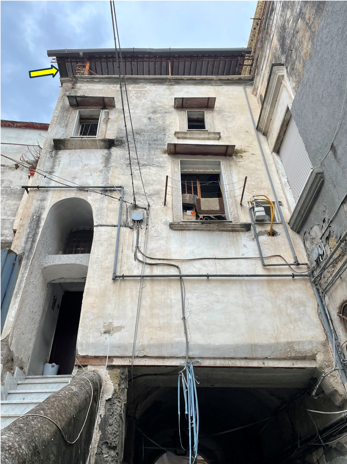
Prospetto sul cortile interno. Si evidenzia il terrazzo a livello dell'immobile staggiato coperto da tettoia in lamiera
