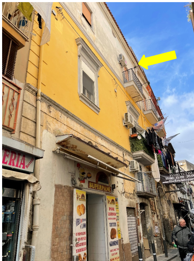
Prospetto principale su via Fontana si evidenzia l'immobile staggito
