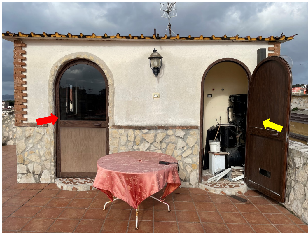
Manufatto sul terrazzo di copertura al terzo piano. Con la freccia rossa si evidenzia la porta di ingresso. Con la freccia gialla si indica l'accesso al ripostiglio.
