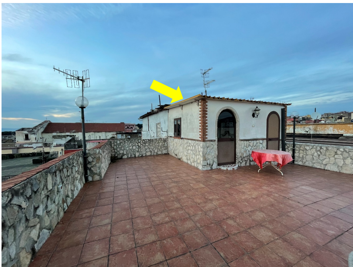
Si evidenzia il manufatto sul terrazzo di copertura al terzo piano
