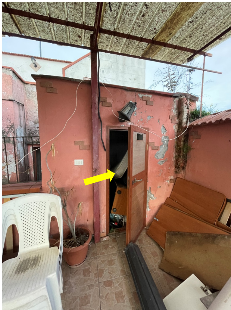
Primo ripostiglio con accesso dal terrazzo a livello
