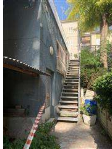
Scala esterna di accesso al PS1 da Via Porta Romana
