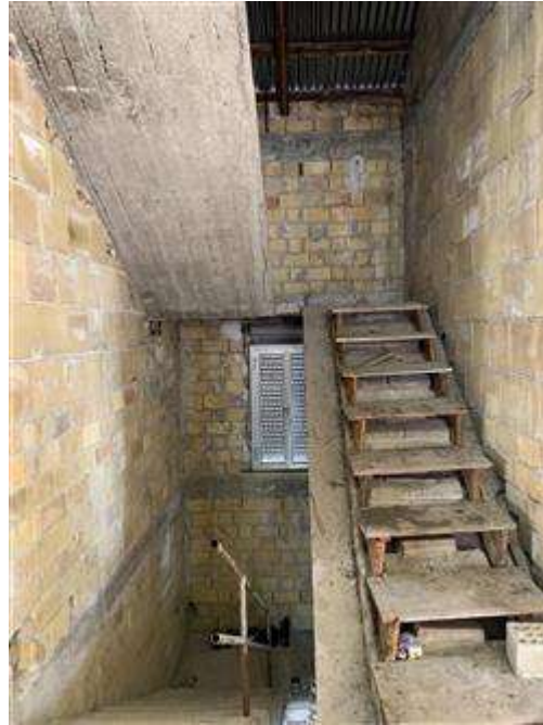
Scala accesso al lastrico dal Piano primo
