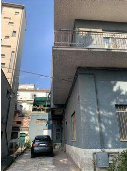
Locale centrale elettrica
