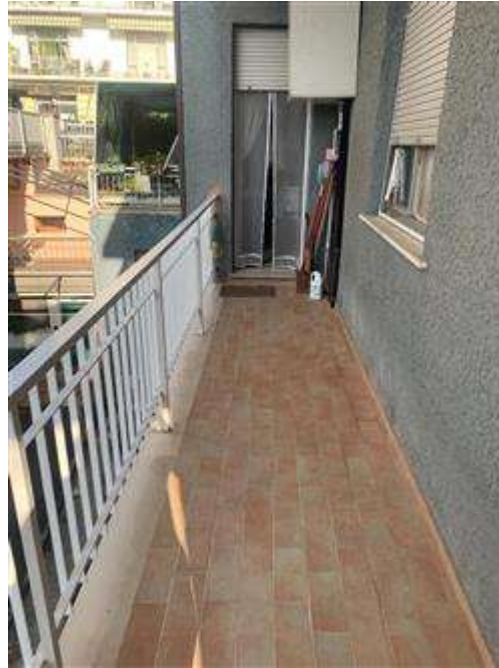
Balcone lato Ovest
