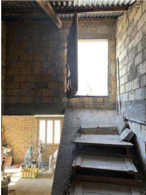
Scala accesso al lastrico
