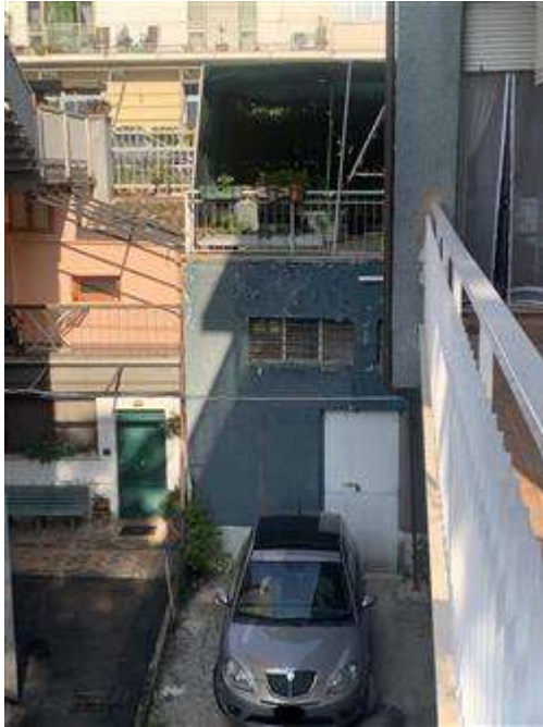
Locale centrale elettrica
