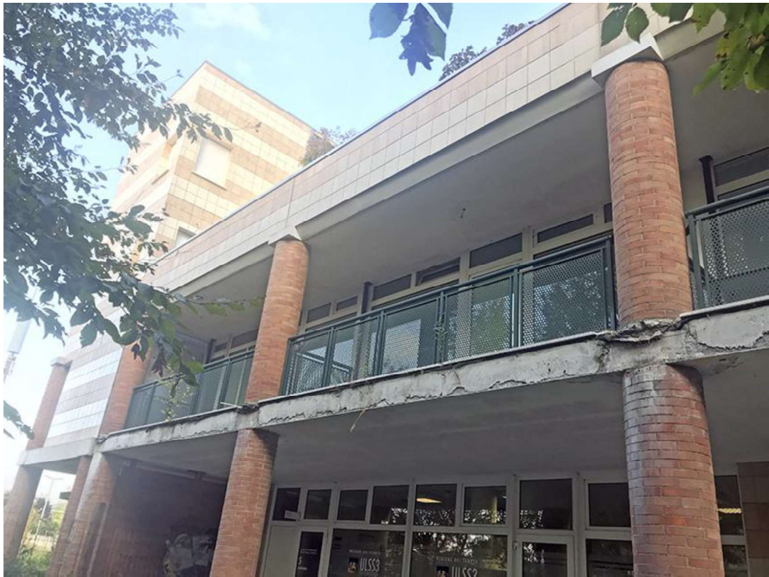
Il fronte principale verso Viale San Marco con le logge degli uffici.
