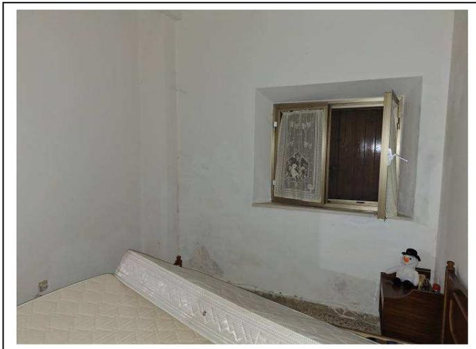
FOTO n° 23 – Vista umidità di risalita sul muro controterra
