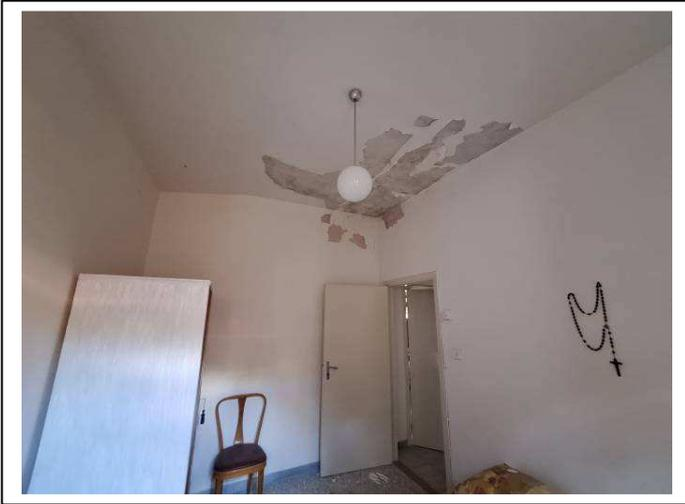
FOTO n°15 – Vista infiltrazioni sul soffitto della camera
