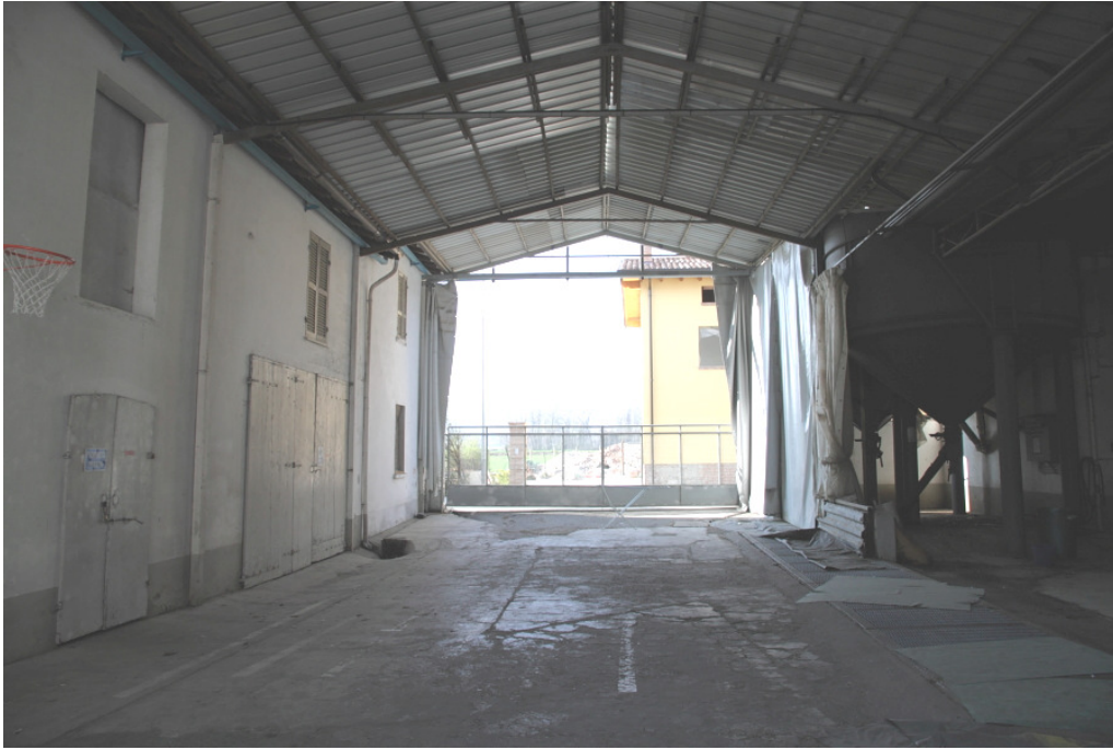
Foto 23 depositi lotto 3 e 4 tettoie comuni viste dal cortile
