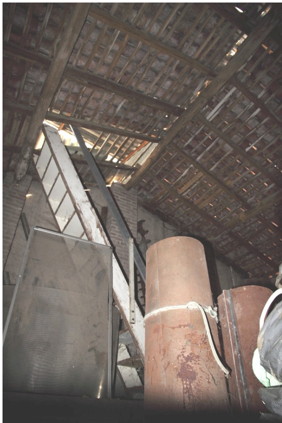
Foto 22 depositi lotto 4 vista della copertura
