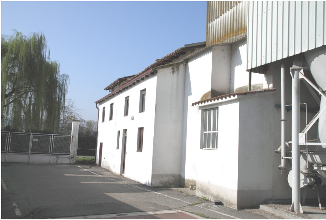
Foto 19 abitazione del custode e depositi lotto 4 vista dal retro
