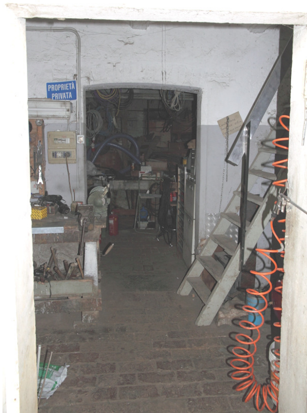
Foto 20 depositi lotto 4 vista dal cortile
