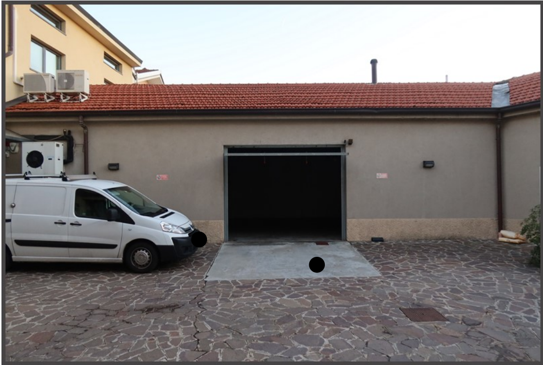
5 – ingresso autorimessa comune
