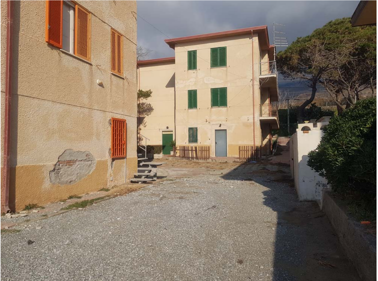
FOTO 09 esterno del fabbricato spazio comune
