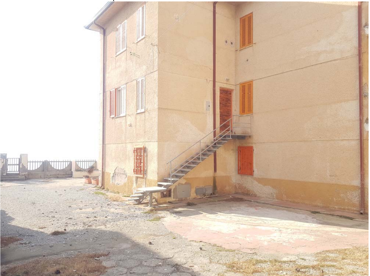
FOTO 08 esterno del fabbricato spazio comune
