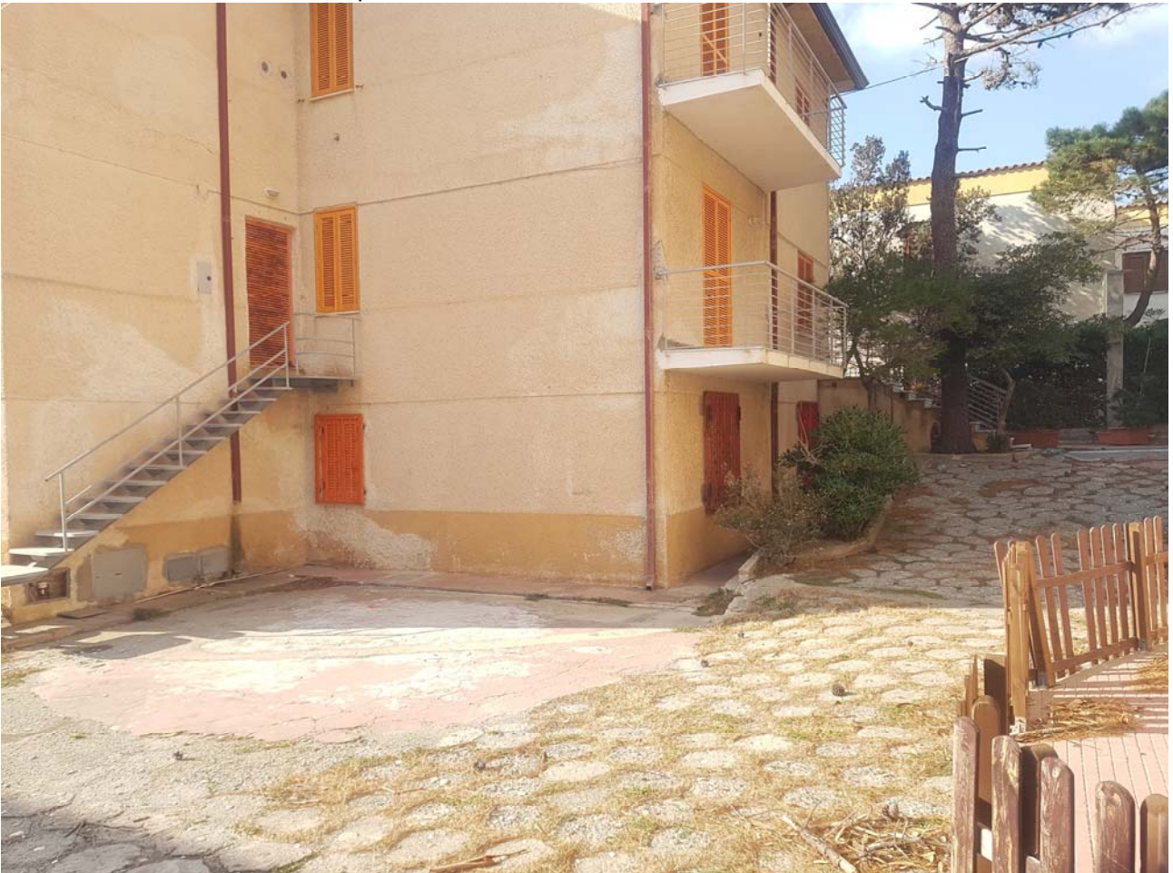
FOTO 06 esterno del fabbricato spazio comune
