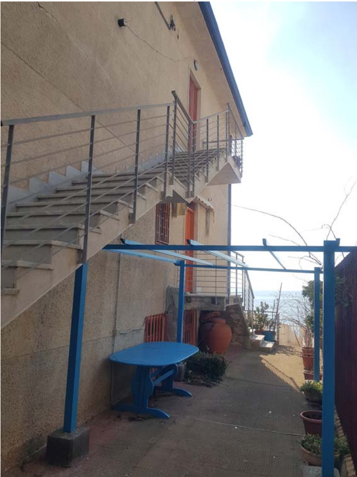
FOTO 04 esterno del fabbricato spazio comune
