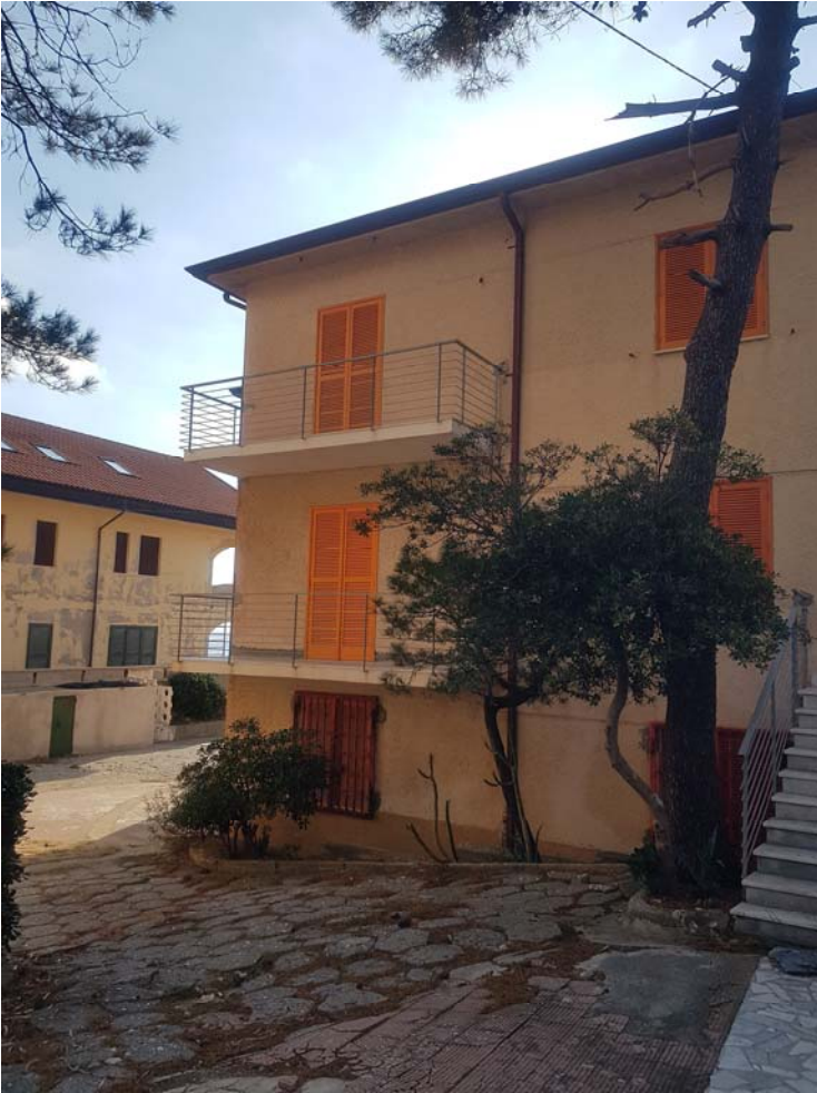
FOTO 05 esterno del fabbricato spazio comune
