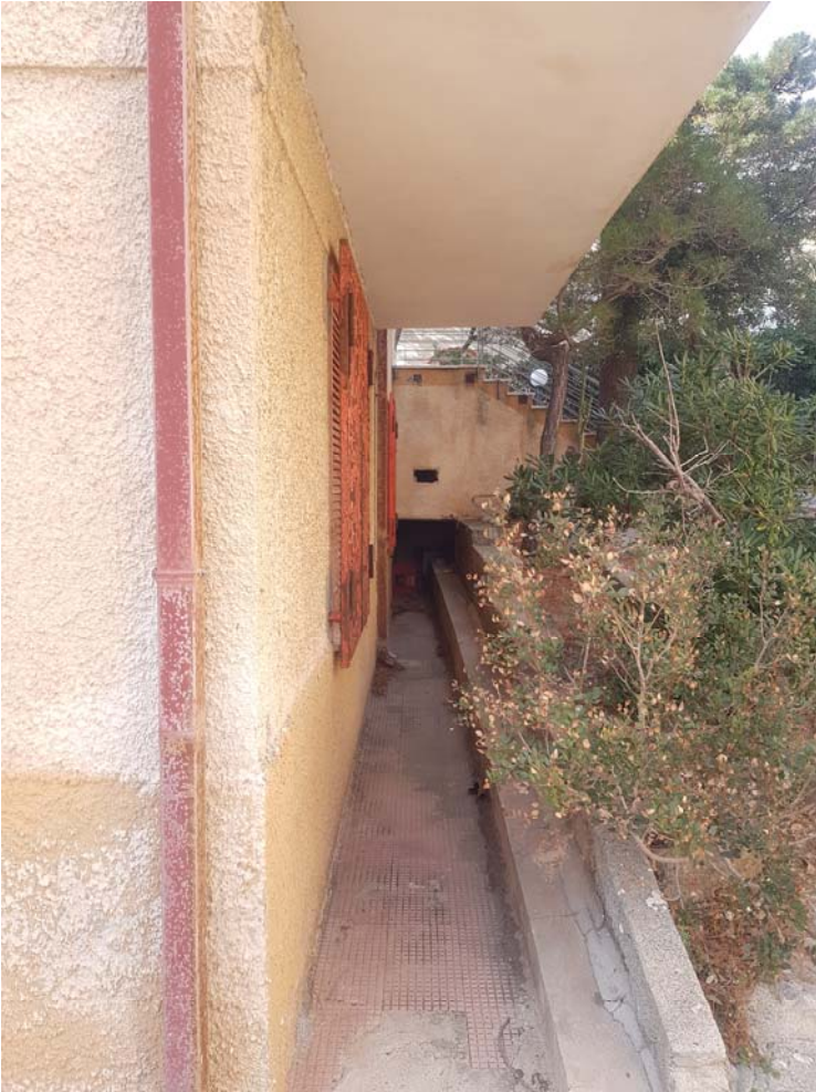
FOTO 07 esterno del fabbricato spazio comune
