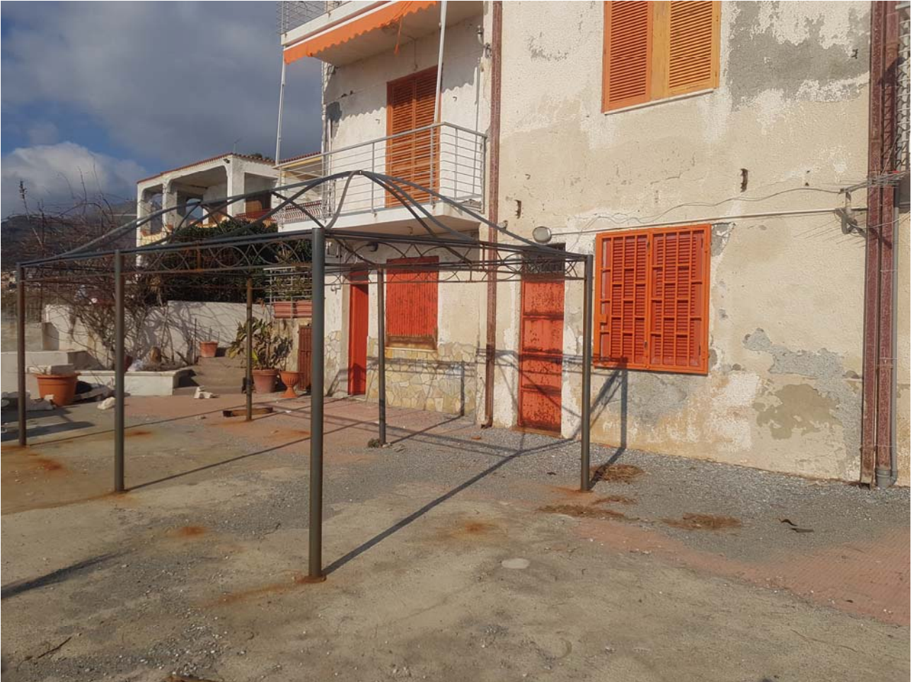
FOTO 11 esterno del fabbricato spazio comune
