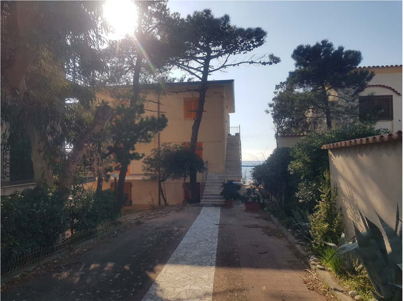
FOTO 03 esterno del fabbricato spazio comune
