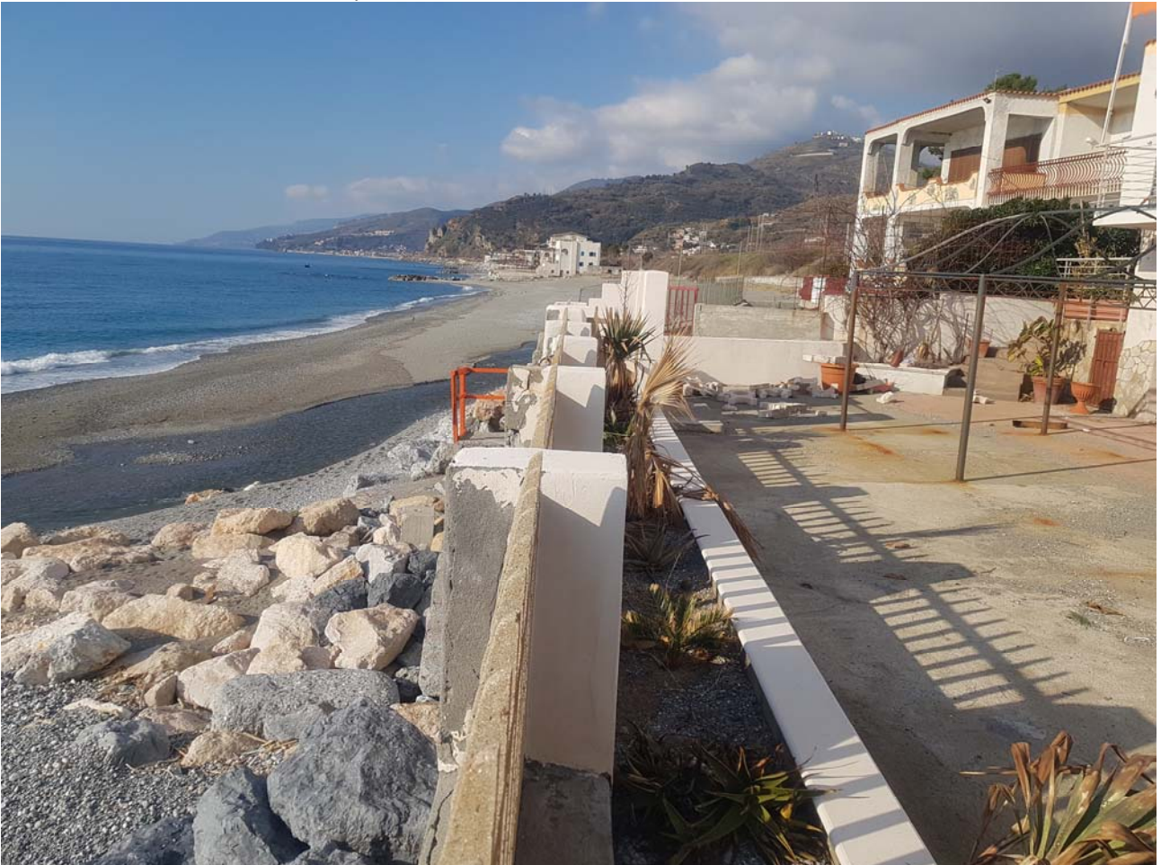
FOTO 12 esterno del fabbricato spazio comune
