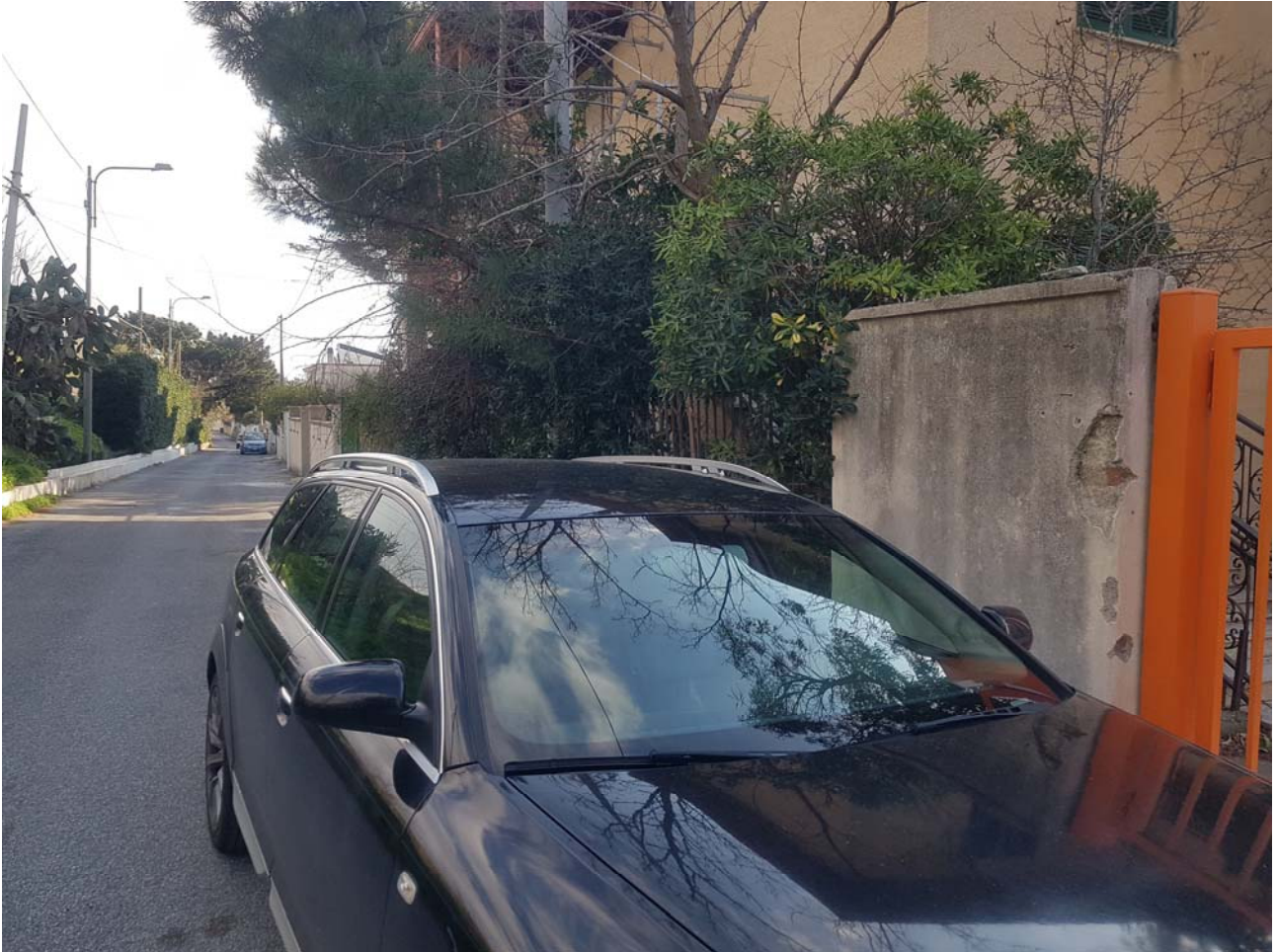
FOTO 01 ingresso complesso edilizio di due fabbricati
