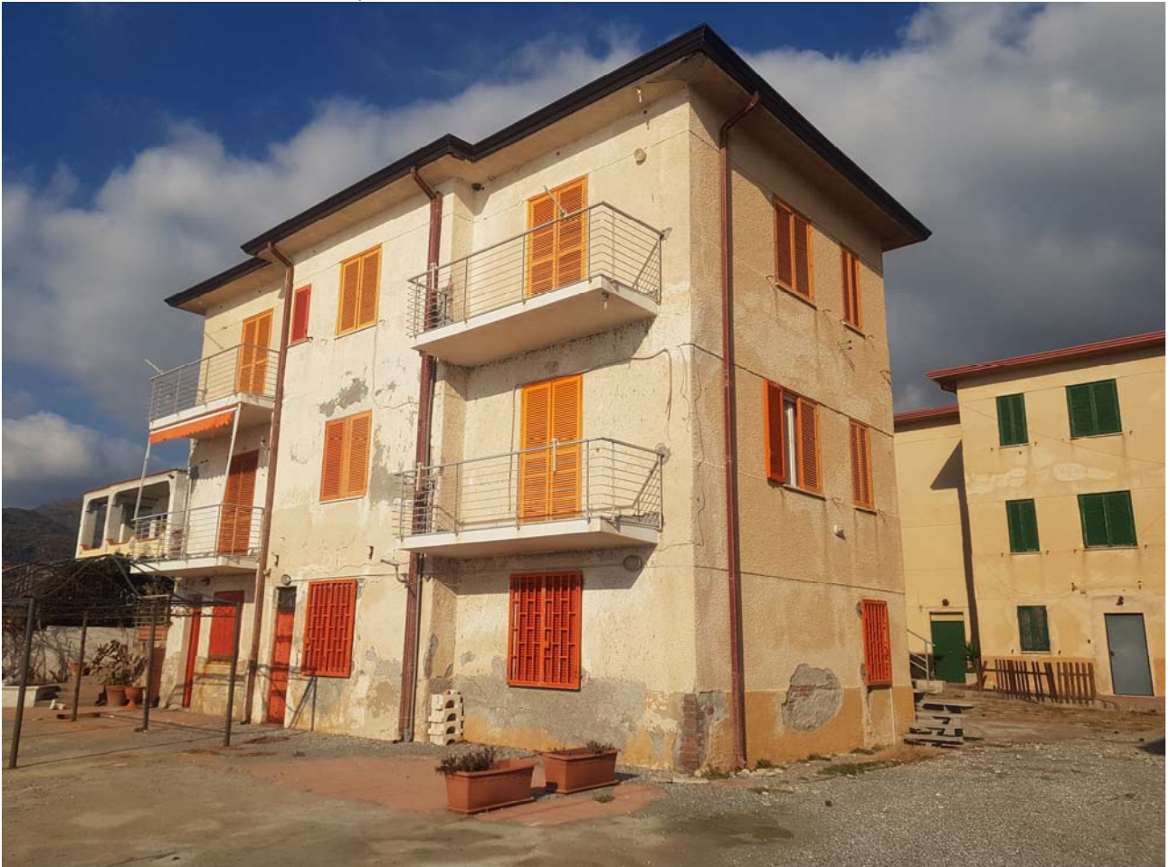
FOTO 10 esterno del fabbricato spazio comune
