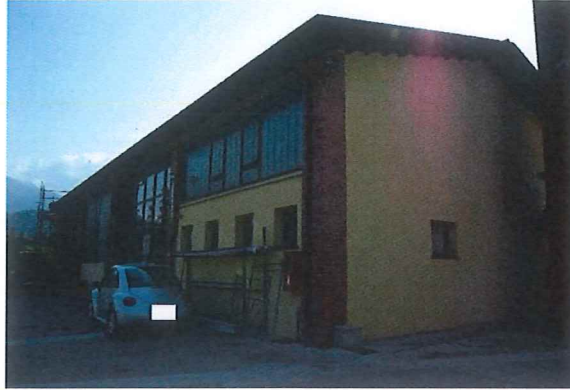
Prospetto su cortile interno, lato ingresso
